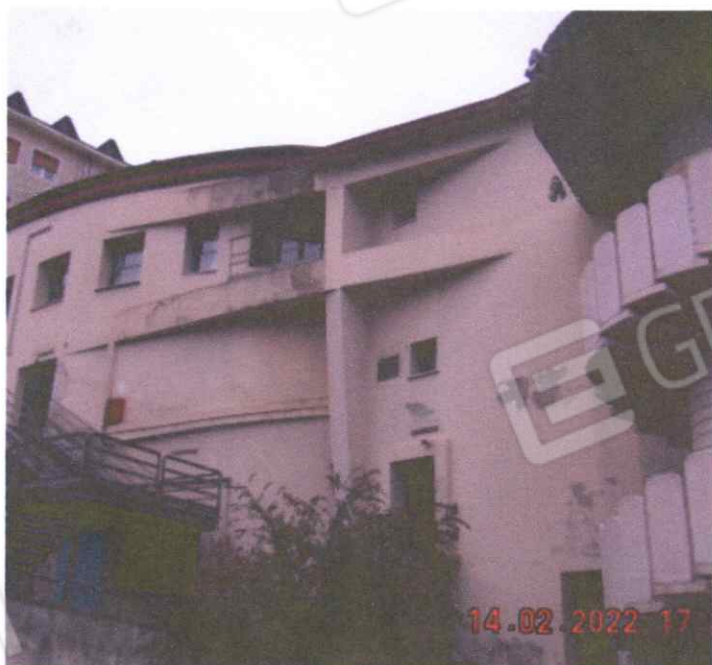
Vista esterno fabbricato da Via Massimo D'Azeglio
