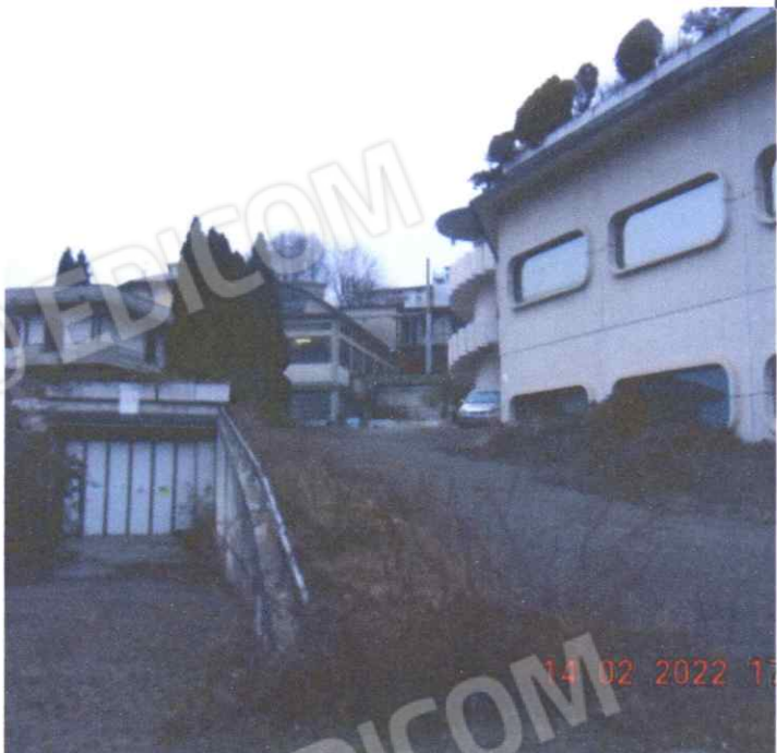
Percorso per accesso alla discoteca non realizzato
