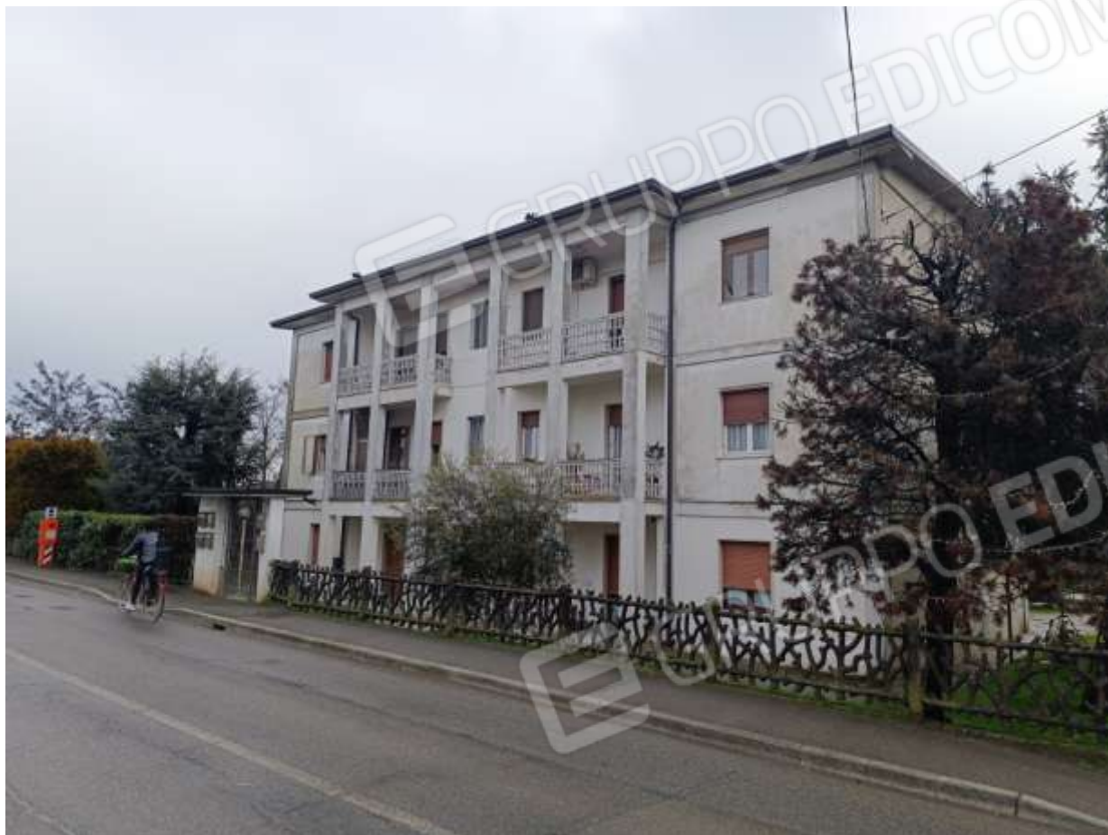
Foto 1: Prospetto Est fabbricato
