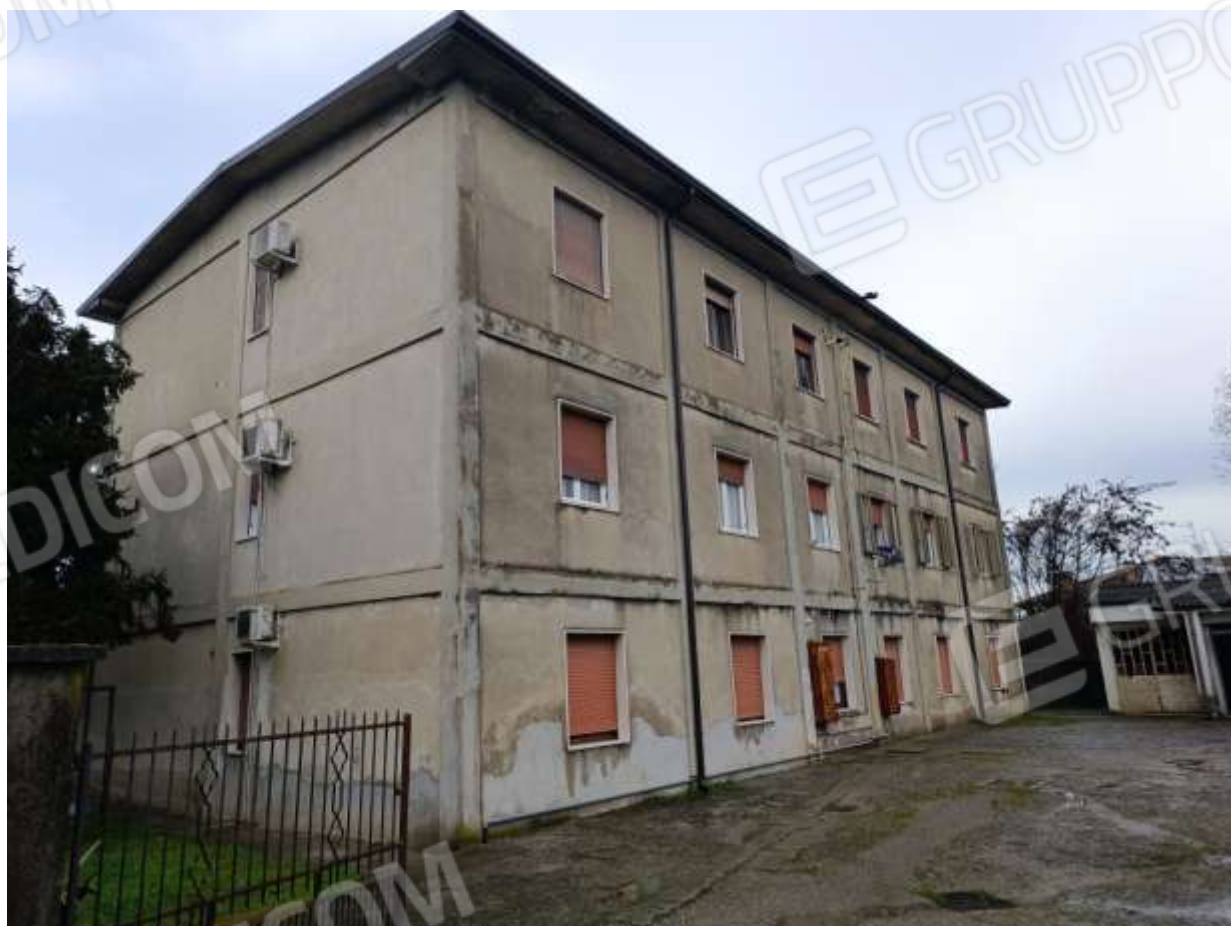
Foto 2: Prospetto Ovest fabbricato
