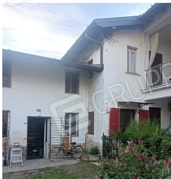
Prospetto ovest con i corpi ripostiglio
