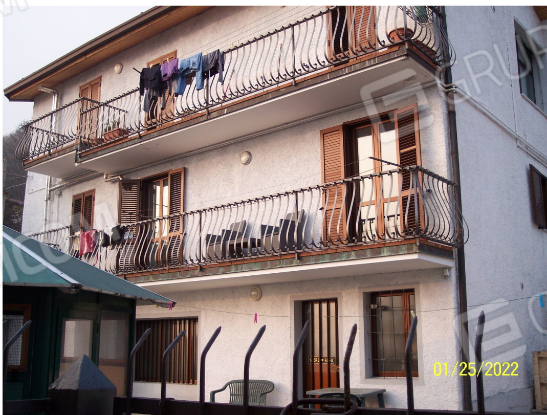
Foto n° 2 - Appartamenti Via Santello 24 (Lotto 4)
