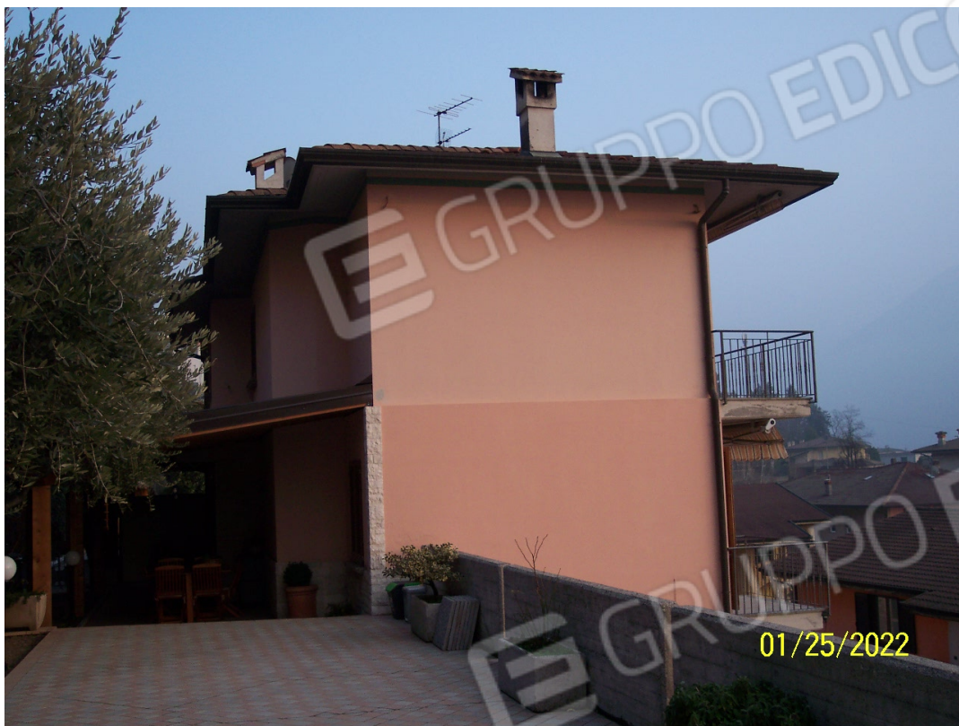
Foto n° 10 - Esterno appartamento Via Santello 24/B (Lotto 3 Sub. 4)
