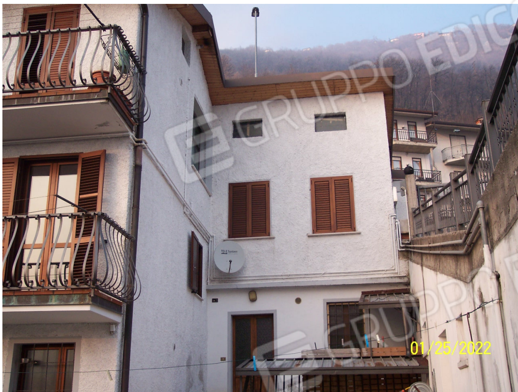
Foto n° 3 - Appartamenti Via Santello 24 (Lotto 4)
