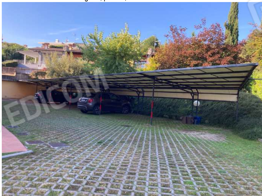
2 Archivio: IMG – 4851 Posto macchina Immobile identificato al NCT Foglio 6, p.IIa 49, sub. 19
