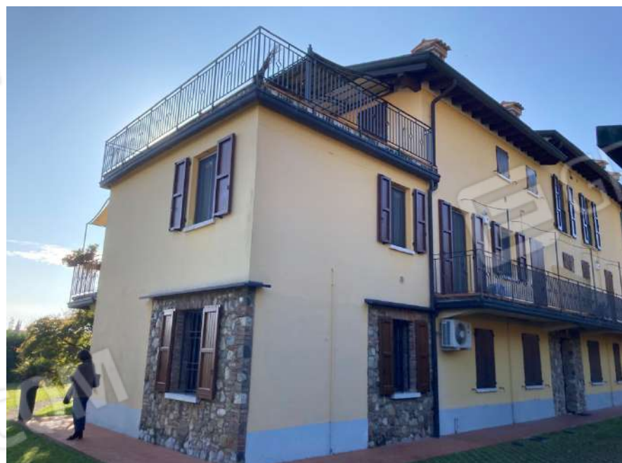
1 Archivio: IMG 4852 – Prospetto nord Immobile identificato al NCT Foglio 6, p.IIa 49,
