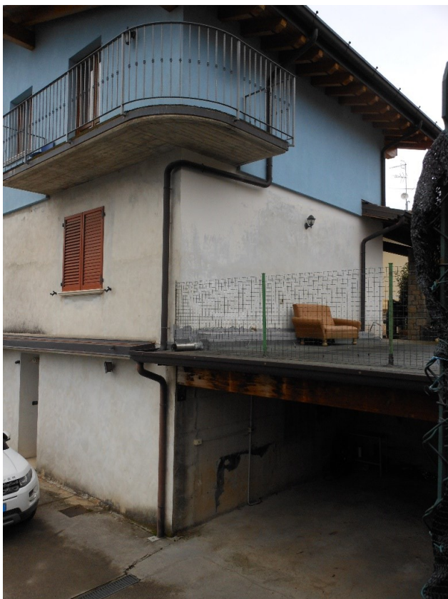
FOTO 20 – Retro fabbricato e autorimessa coperta
