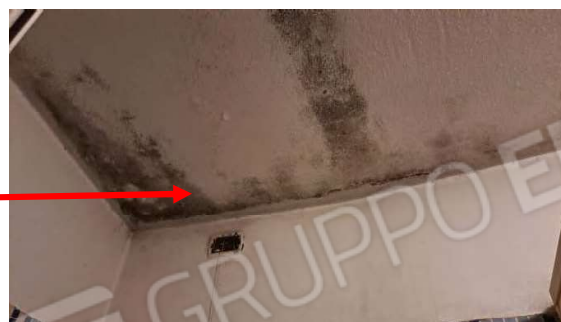
Evidenze di muffa e umidità nel bagno
