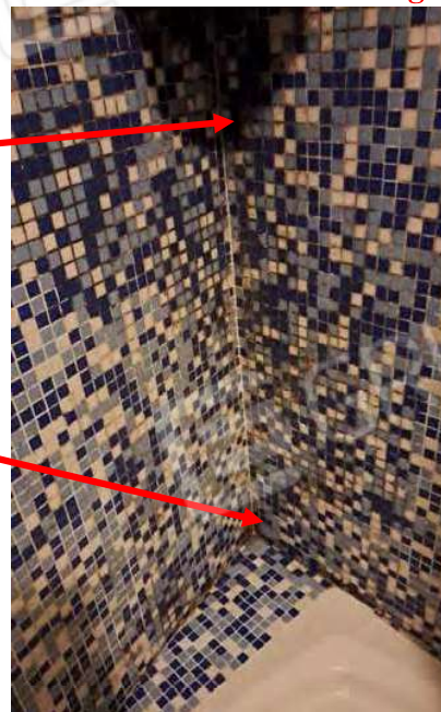
Evidenze di muffa e umidità nel bagno
