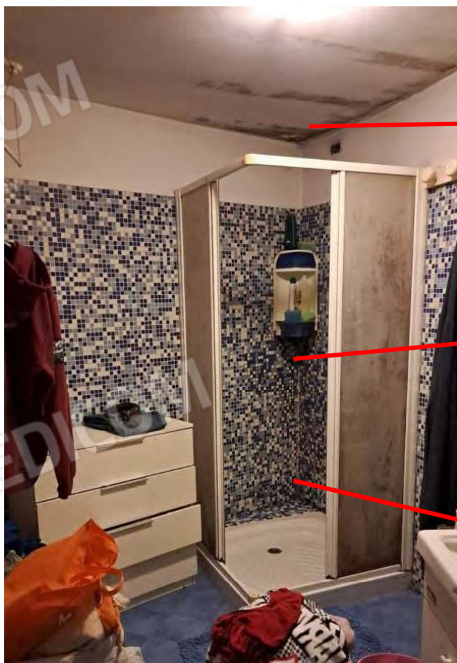
Evidenze di muffa e umidità nel bagno
