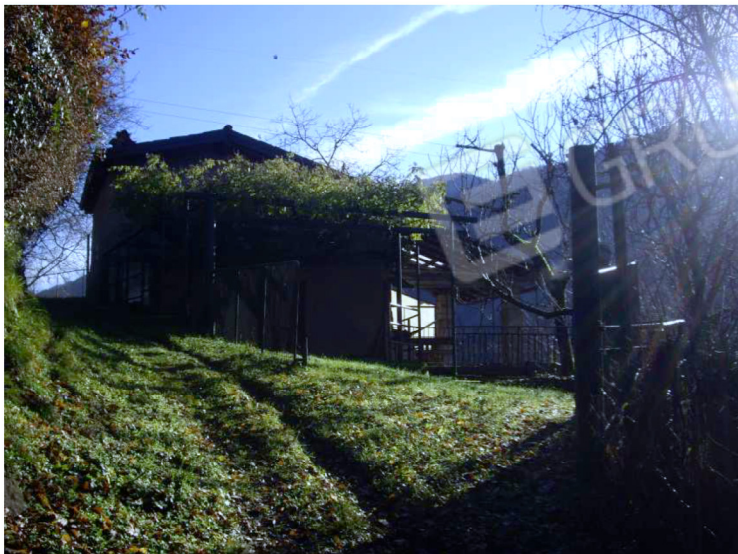
prospetto ovest – accesso al fabbricato
