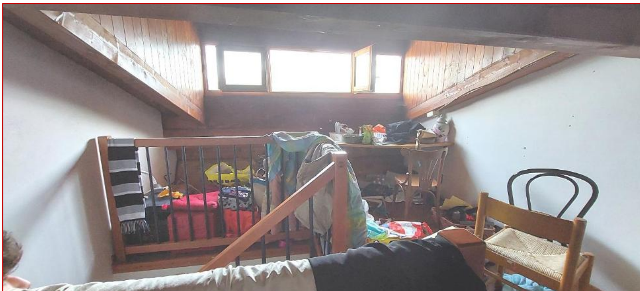
Foto n. 10 – sottotetto lato est
