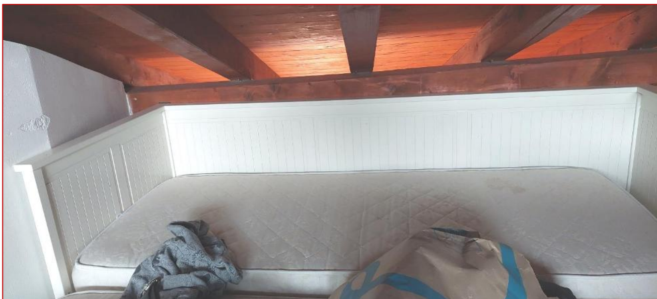
Foto n. 11 – sottotetto lato ovest
