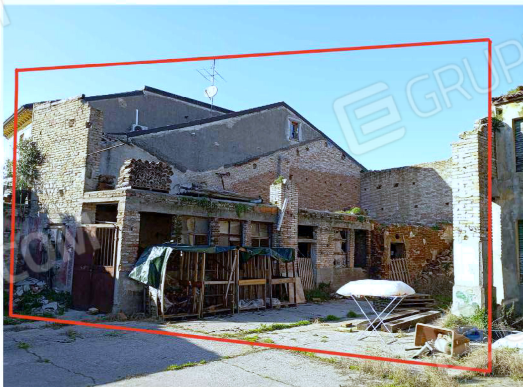
Vista esterna Via Zanardelli n. 3 -Fiesse- Subalterno n. 20 Locali portico, deposito attrezzi e fienile
