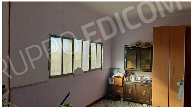
FOTO 16: VERANDA CHIUSA E FINESTRATA
