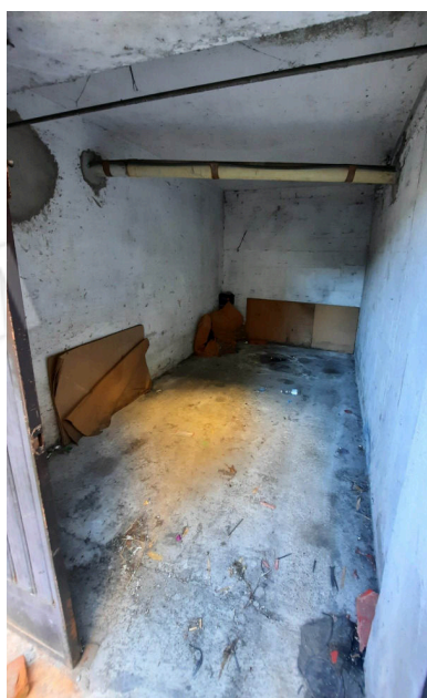
FOTO 23: AUTORIMESSA (PRESENZA DI SERVITU' IMPIANTISTICA)
