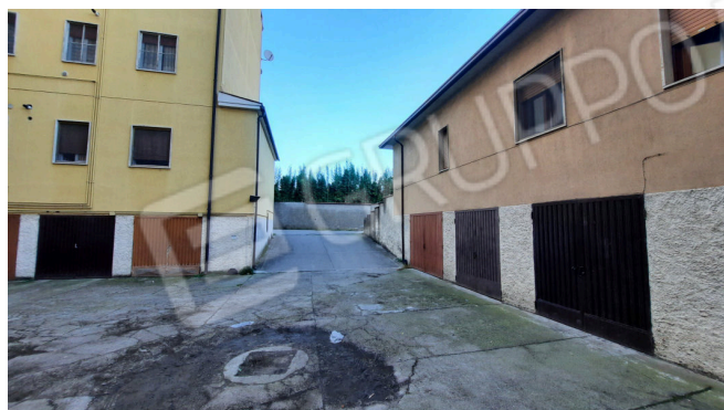
FOTO 24: VISTA CORTILE COMUNE
