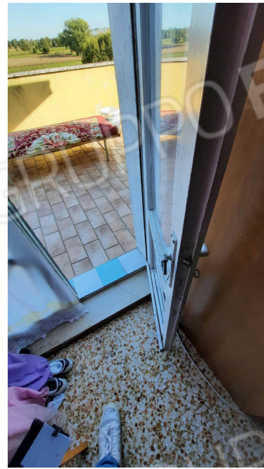
FOTO 12: PORTAFINESTRA DI ACCESSO ALLA TERRAZZA A EST
