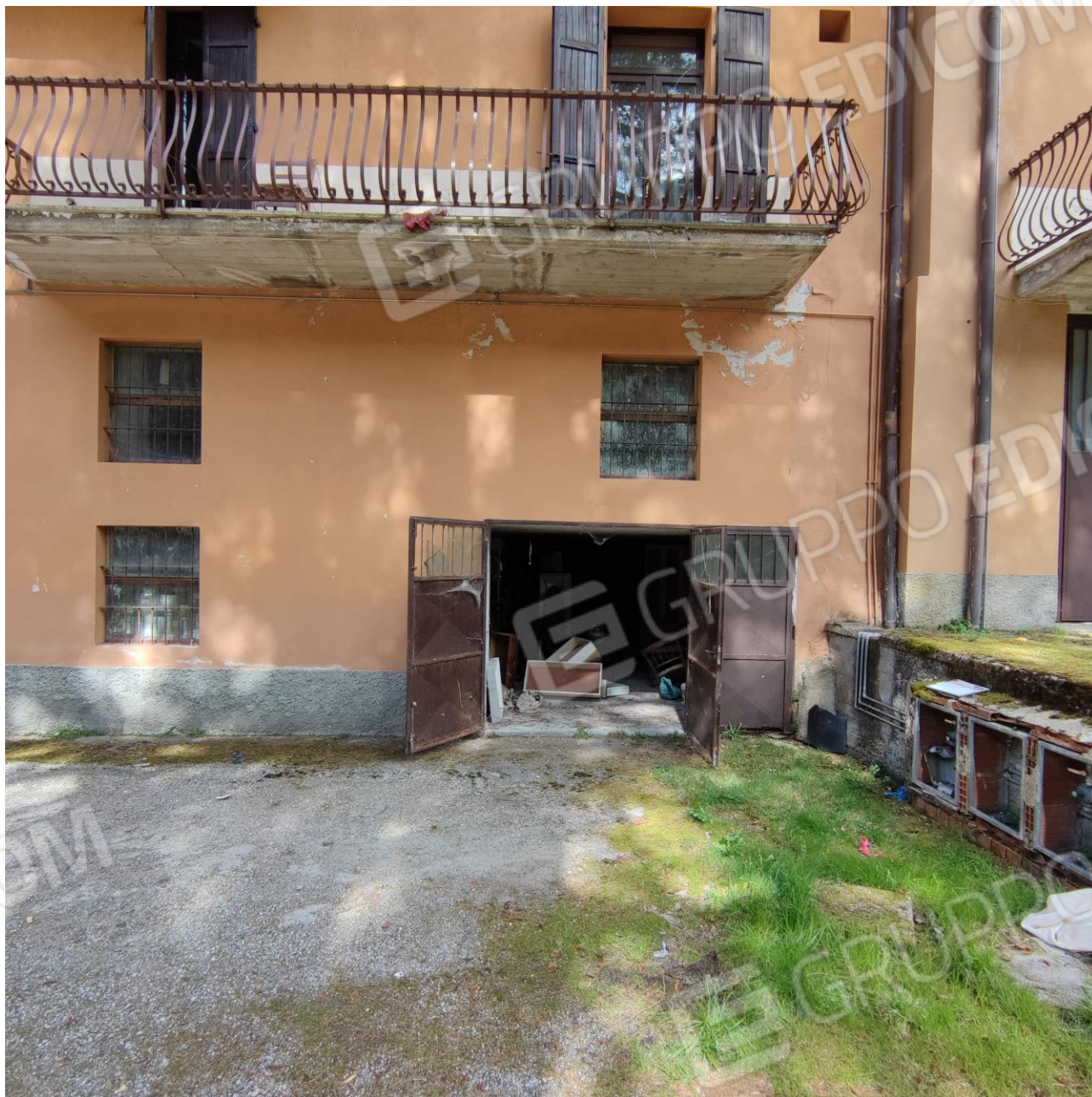
FOTOGRAFIA N. 19 -INGRESSO ALLE UNITA' ESECUTATE ACCATASTATE AUTORIMESSE
