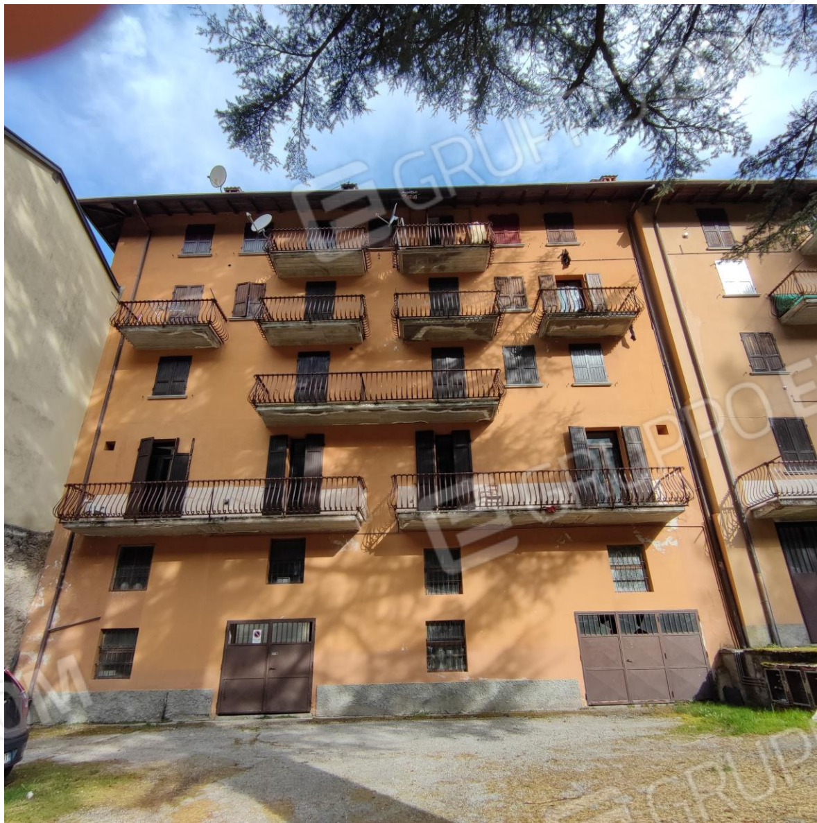
FOTOGRAFIA N.5 – IL CORPO COMDOMINIALE AD OVEST OVE SI APRE , A DESTRA. L'ACCESSO CARRAIO ALLE DUE UNITA' ESECUTATE A DESTINAZIONE BOX
