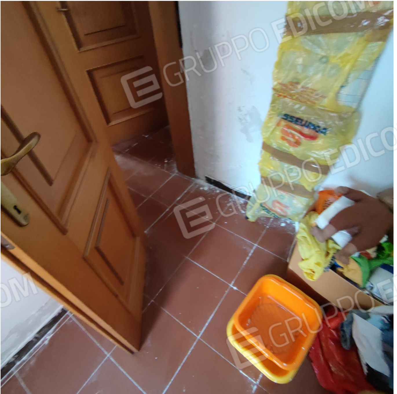
FOTOGRAFIA N. 18 - LOCALE A DISPOSIZIONE LATO SUD
