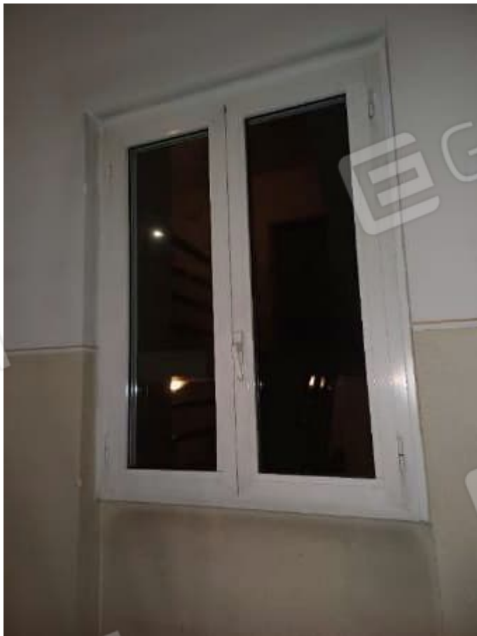
Finestre vano scale in PVC - sostituite
