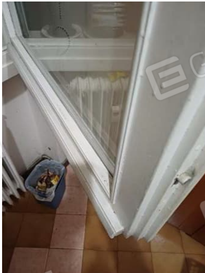
Finestre in legno con vetrocamera singola
