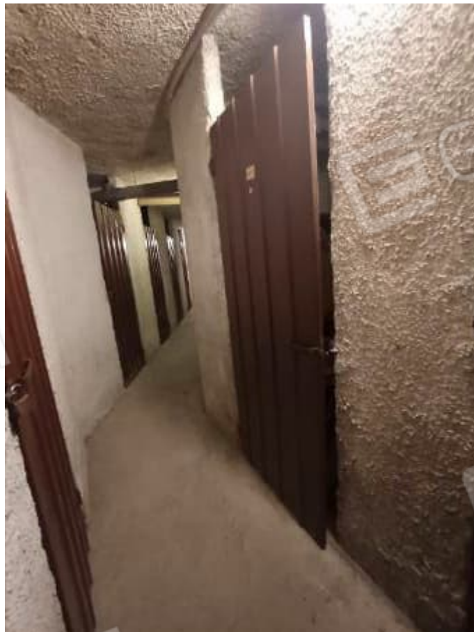
Cantina esclusiva – Porta in ferro
