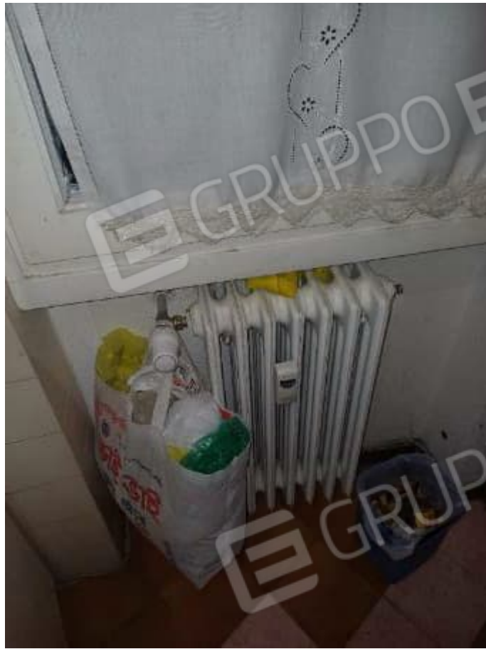
Termosifoni in acciaio con contacalorie
