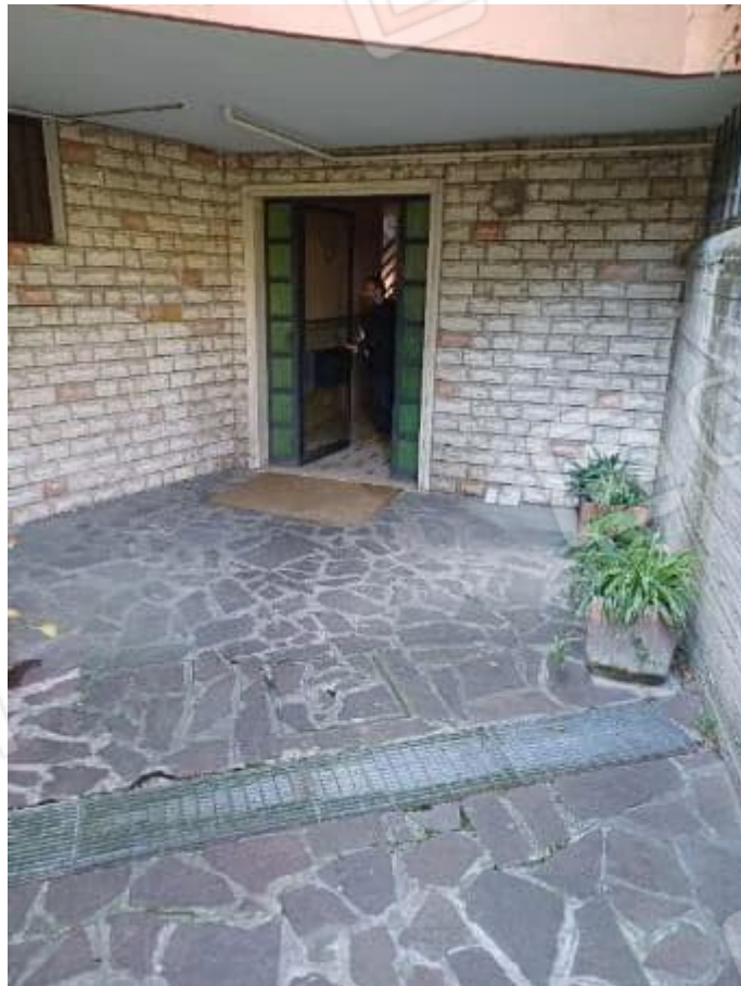
Ingresso condominiale da livello seminterrato
