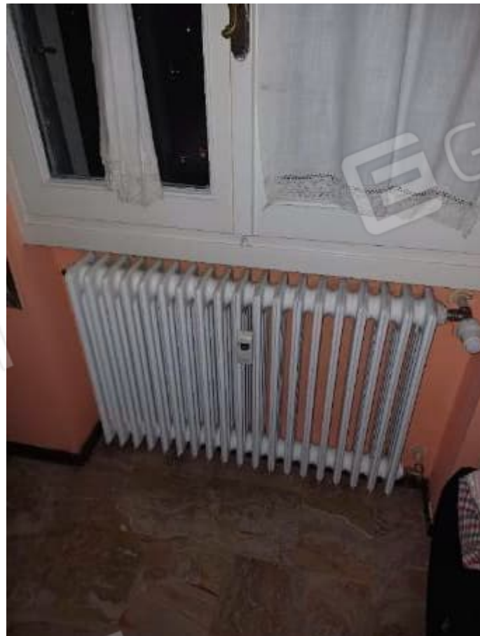
Termosifoni in acciaio con contacalorie
