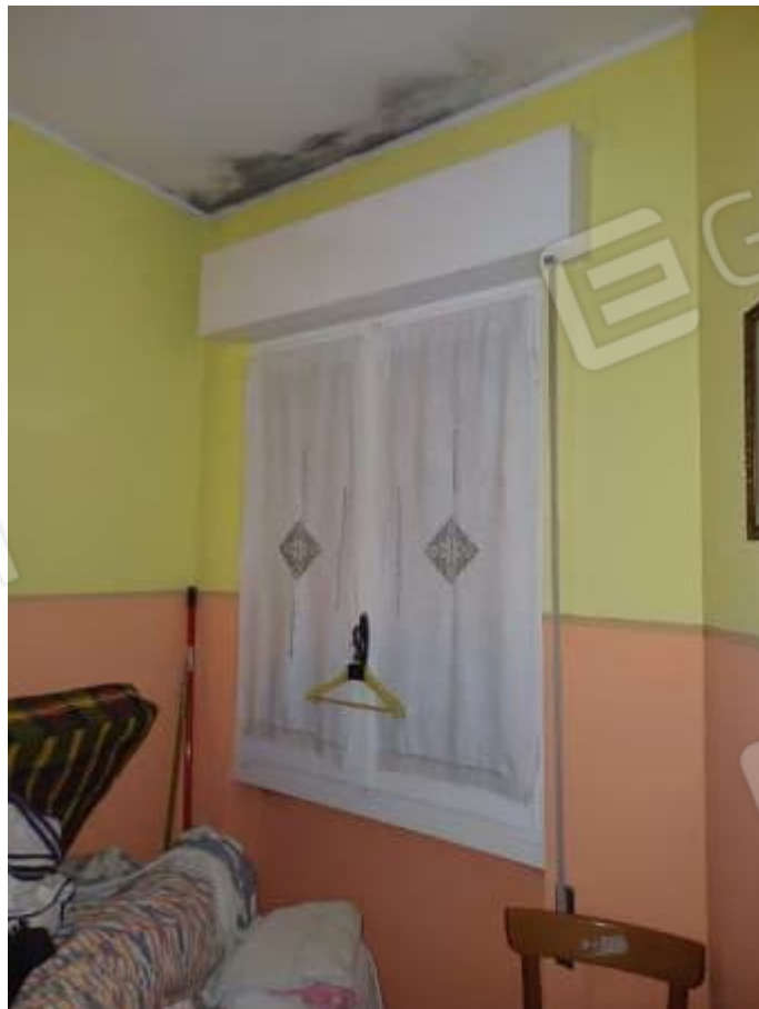
Muffe da ponte termico nella stanza
