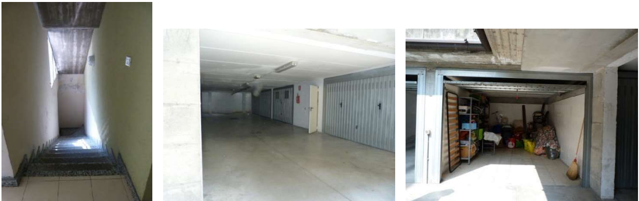
Fig.30,31,32 – Piano Interrato, accesso pedonale , corsello e garage.
