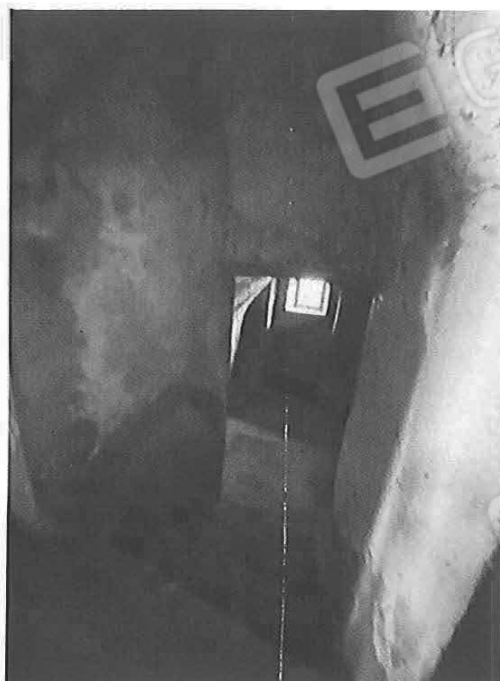
Figura 22 - Vista interna sub. 28
