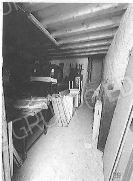
Figura 28 - Vista interna sub. 29
