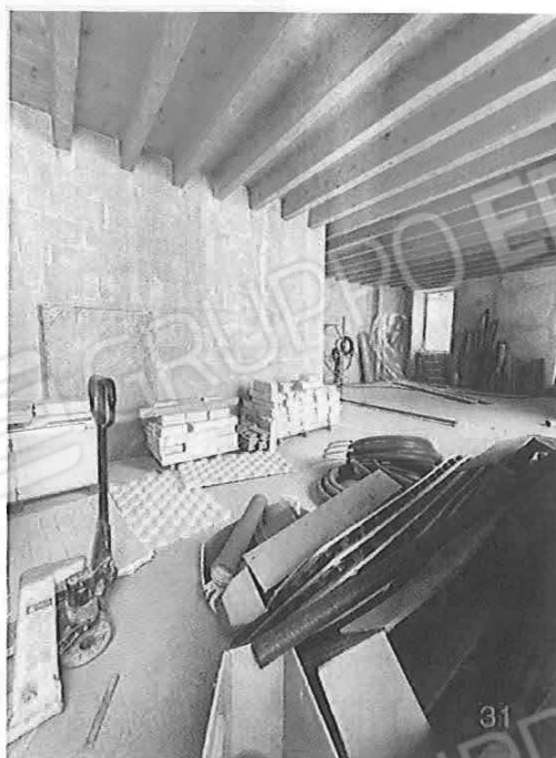
Figura 34 - Vista interna sub. 31
