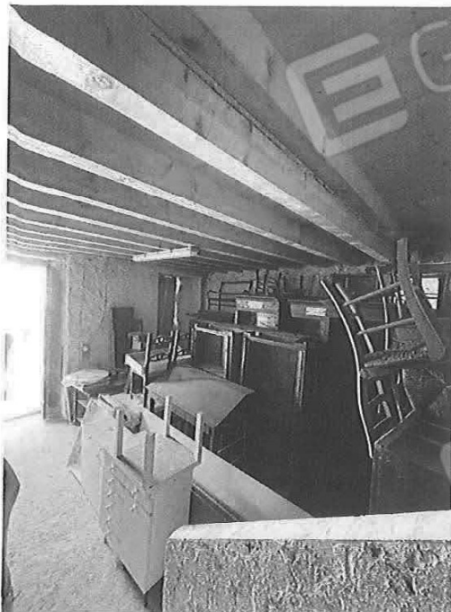
Figura 26 - Vista interna sub. 29
