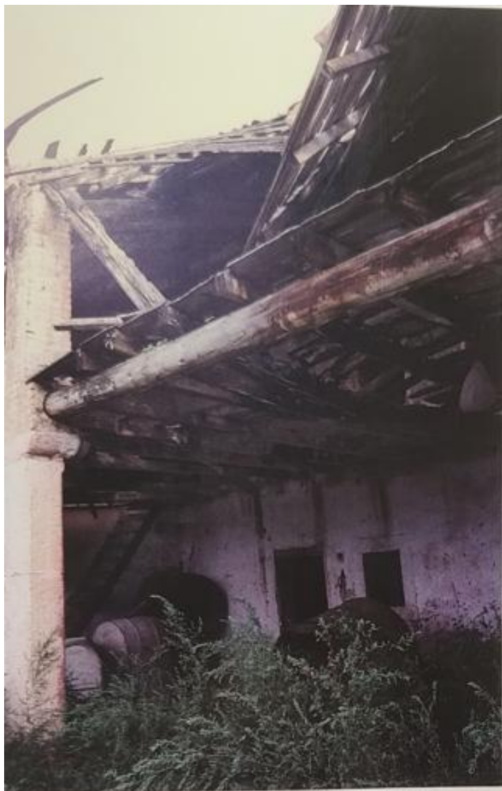
Foto n. 10: Particolare del corpo di fabbrica principale, lato sud-est, portico e loggiato
