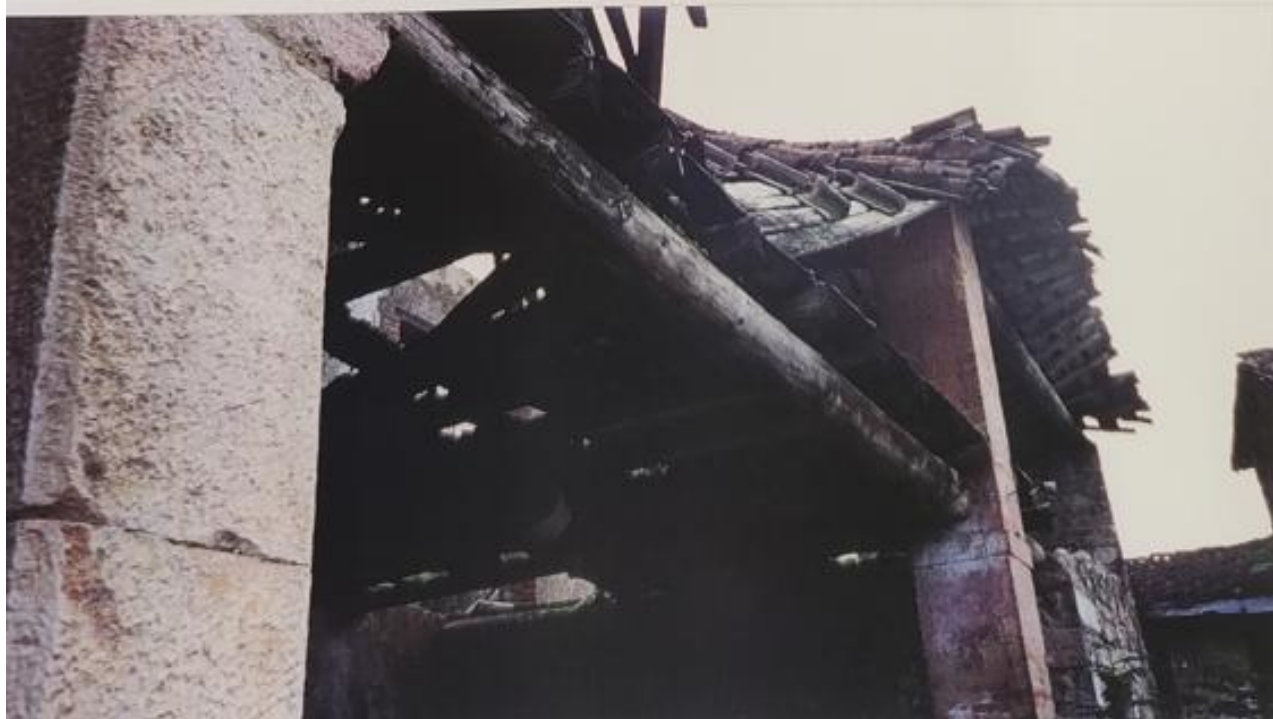
Particolare del corpo di fabbrica principale, lato sud-ovest, soletta del loggiato e resti della copertura Foto n. 11
