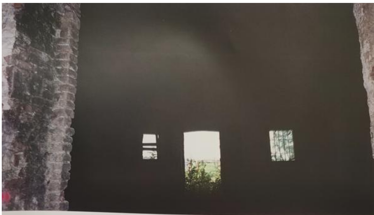
Foto n. 8: Particolare degli interni del corpo di fabbrica principale, piano terra, lato nord
