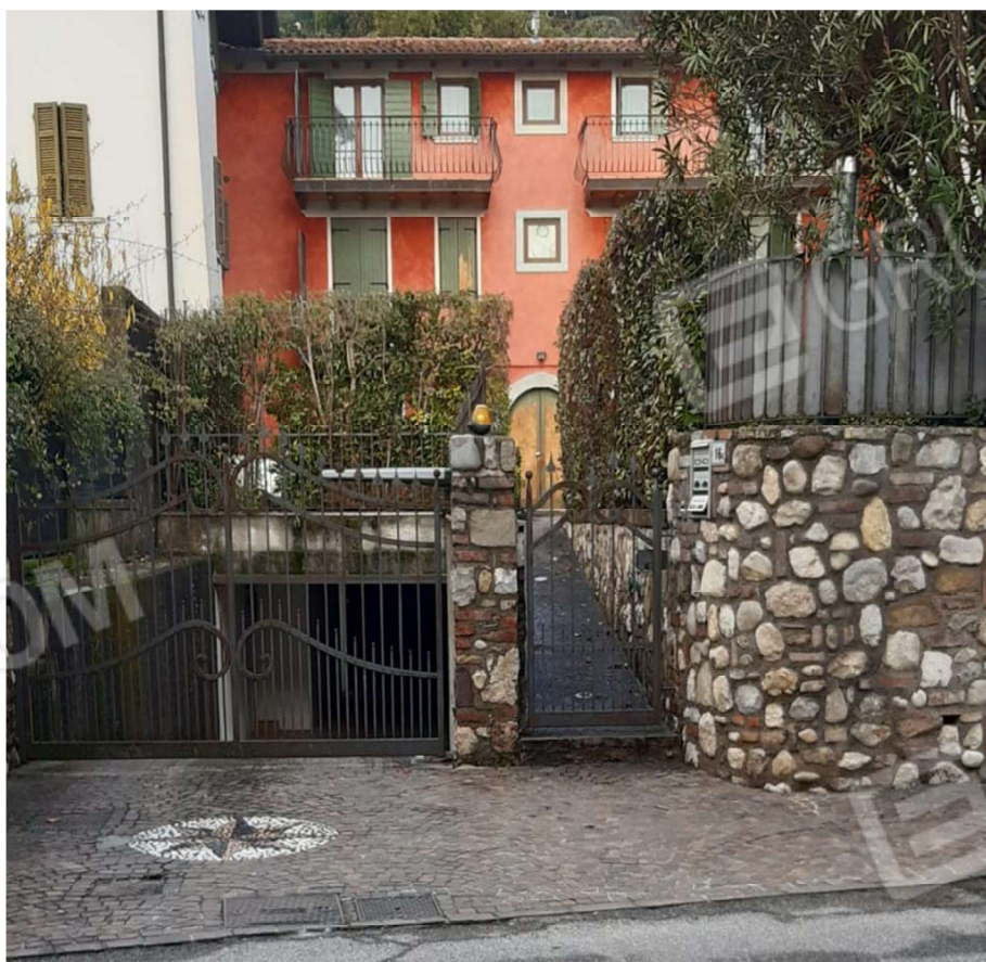
Facciata dalla strada
