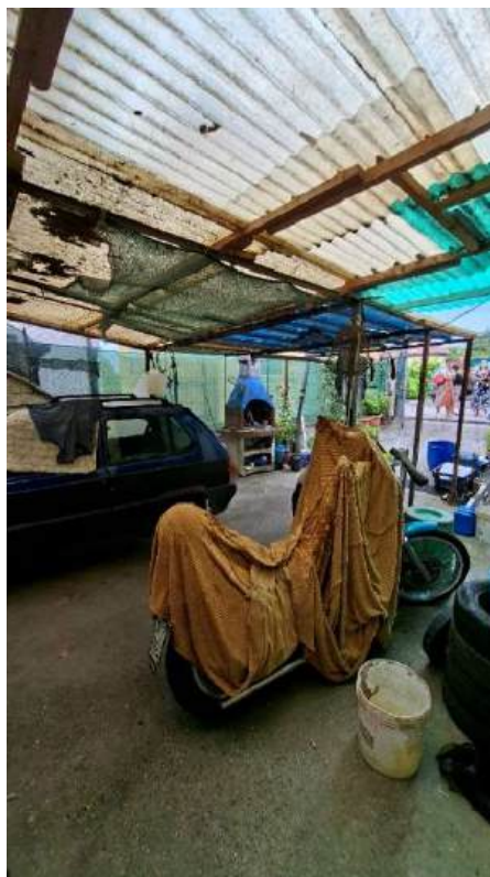
Foto n. 3 – tettoia in plexiglas
