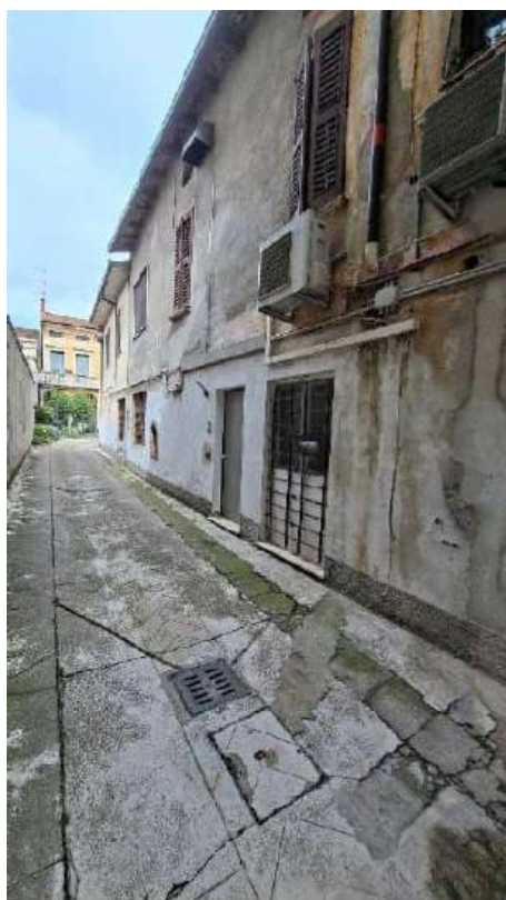
Foto n. 18 – passaggio comune lato verso via XX Settembre
