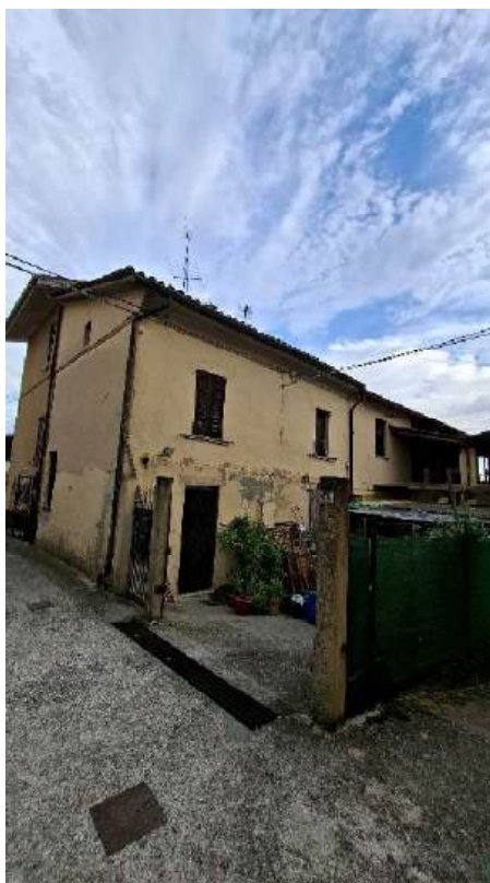
Foto n. 2 – prospetto da via Trento
