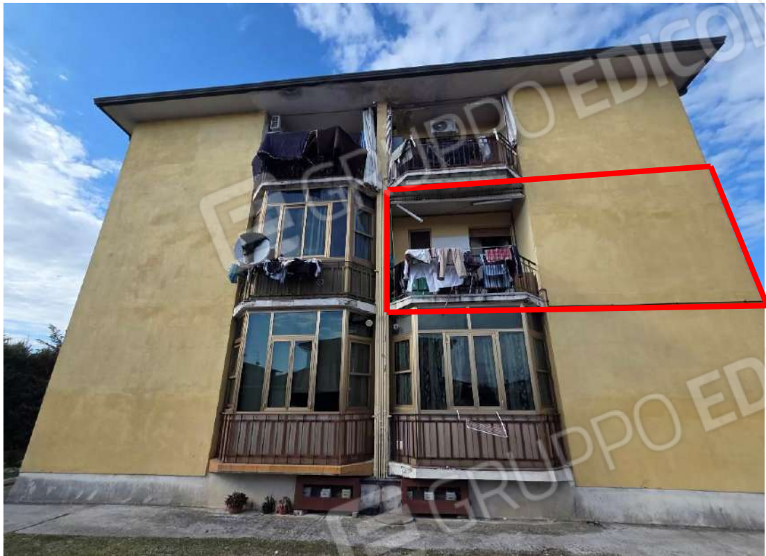
Figura 3 – Vista esterna, del lato sud dell'unità immobiliare oggetto di perizia
