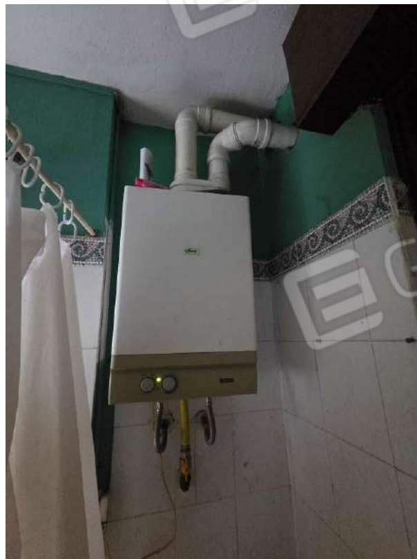
Figura 13 – Vista dello scaldacqua a gas metano, presente nel bagno
