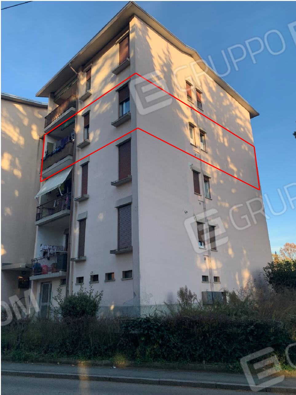
01 Vista esterna da Via Rizzato
