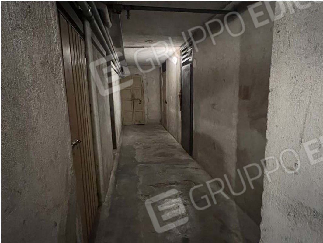
Corridoio cantina interrata
