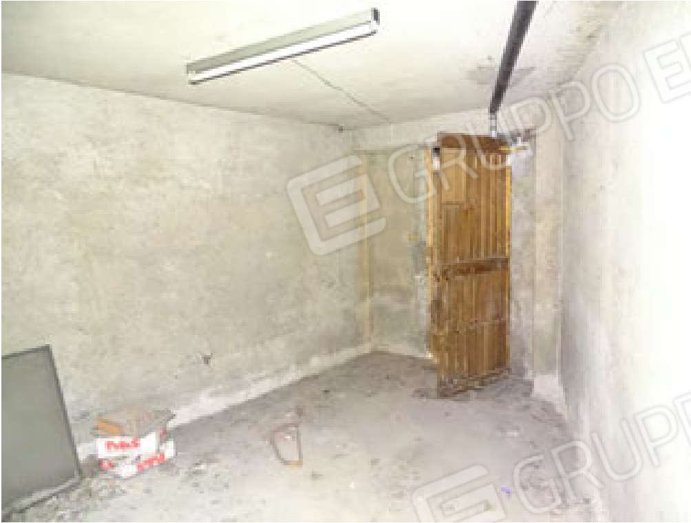
Vista interna cantina
