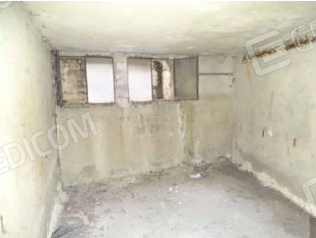
Vista interna cantina
