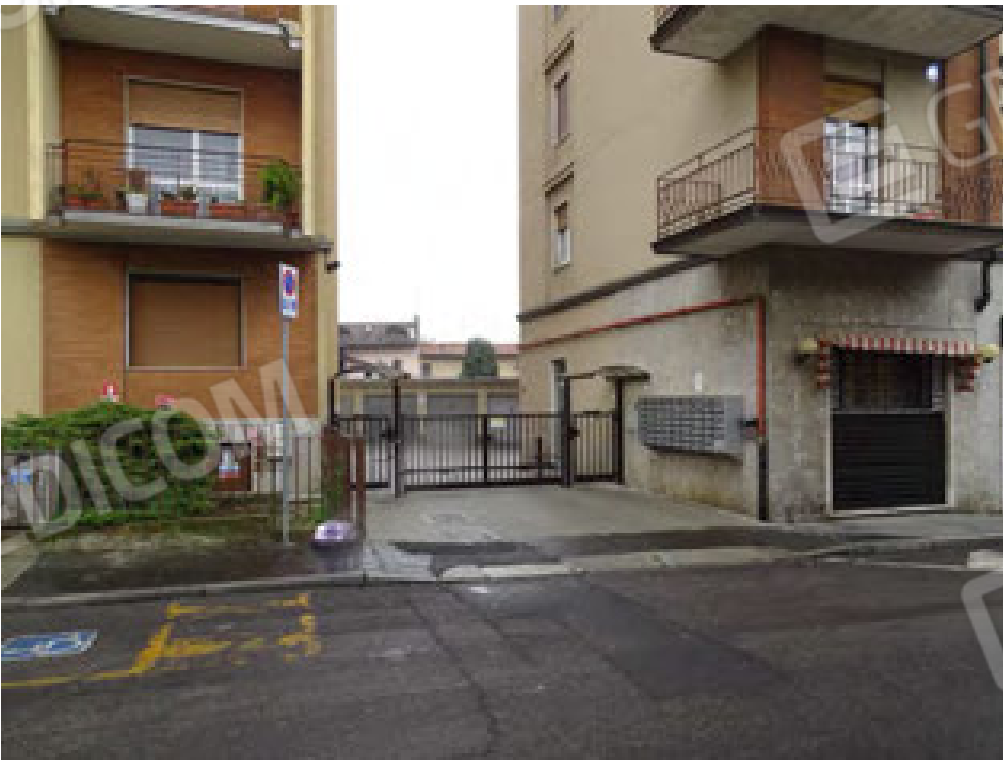
Vista da via Luigi Galvani ingresso carraio e pedonale
