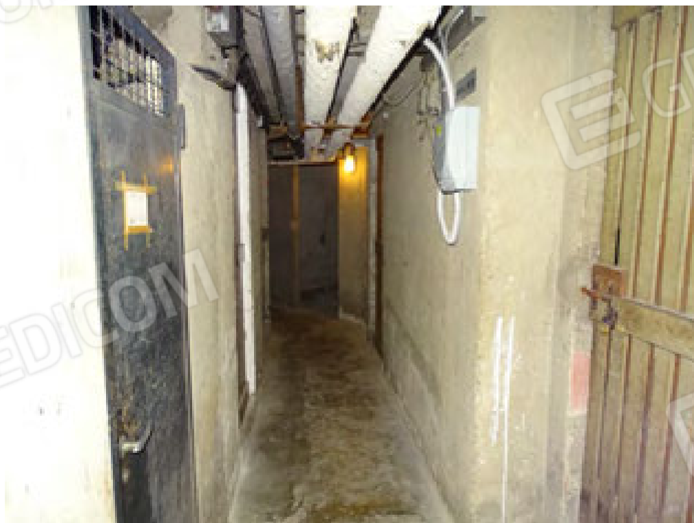
Vista corridoio cantina
