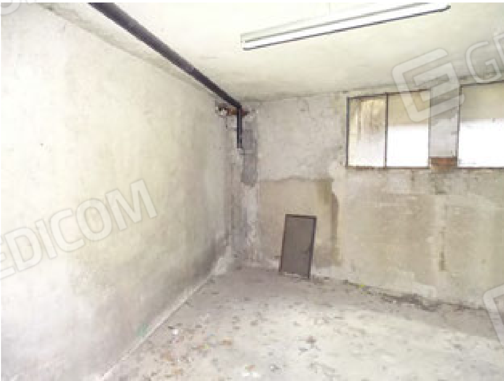
Vista interna cantina
