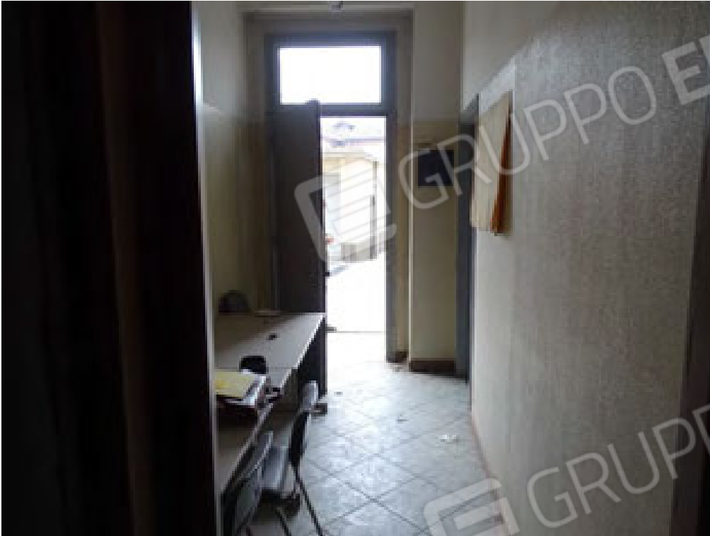
Vista locale retro/ingresso
