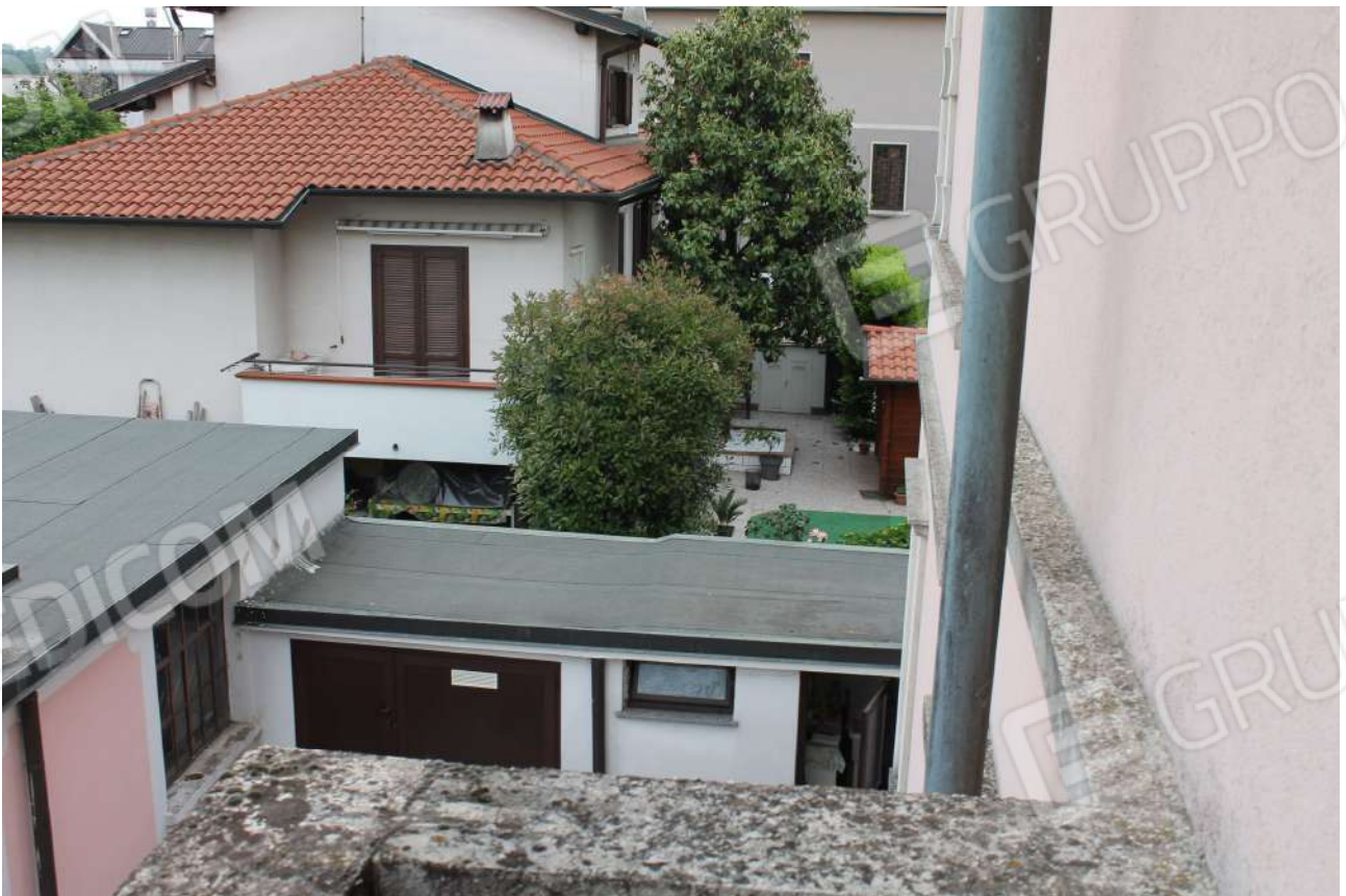
Foto 32 – Vista da balcone P1
