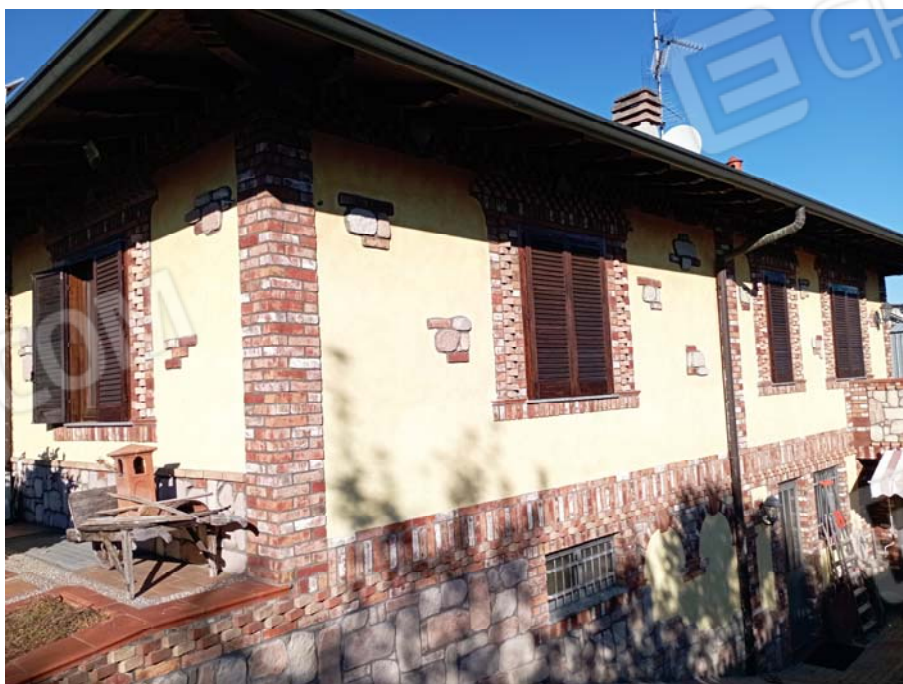
F2 FRONTE DESTRO (RAMPA CARRABILE)
