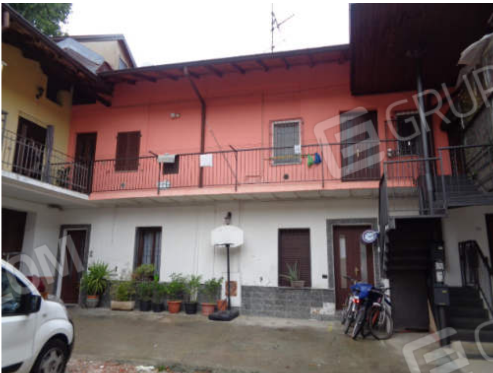
FOTO 2 Vista esterna – Fronte cortile comune
