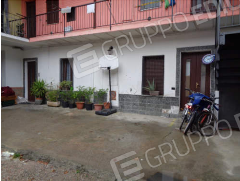
FOTO 3 Vista esterna – Fronte cortile comune
