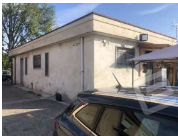
Fronte cortile interno
