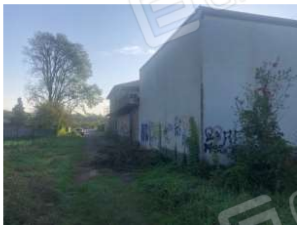
Fronte Nord e Ovest
