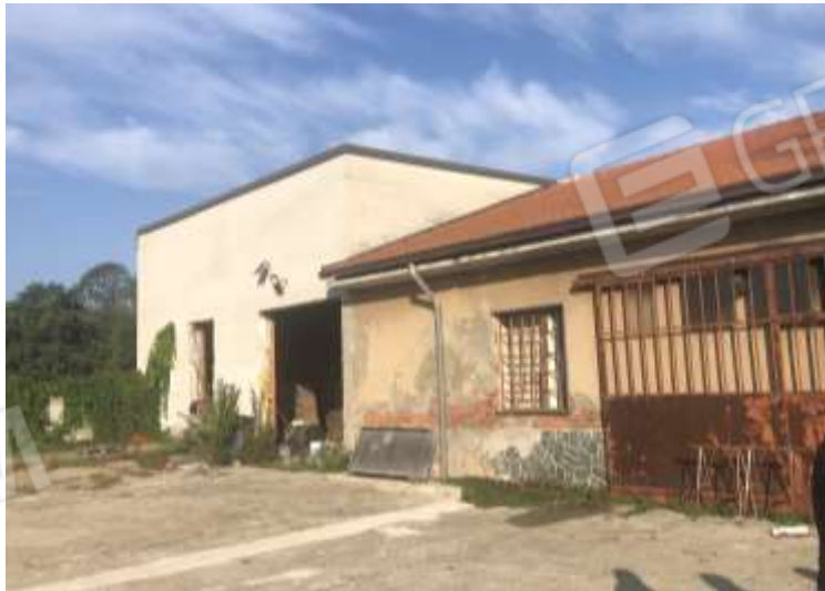
Fronte cortile deposito e magazzino
