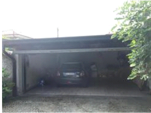
tettoia esterna nel cortile di proprieta'
