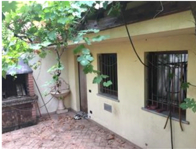
accesso su retro zona cantina
