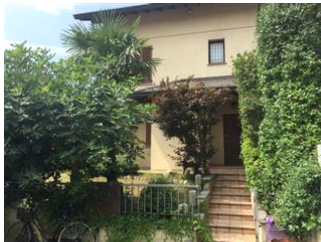
ingresso principale del fabbricato
