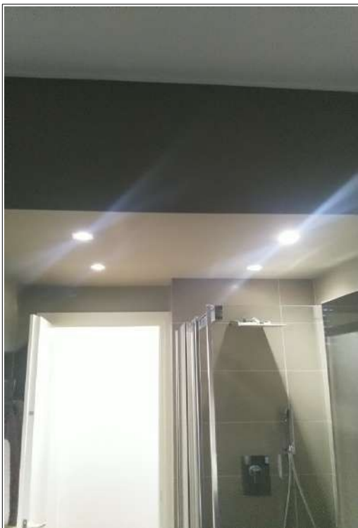
Particolare controsoffittatura del bagno
