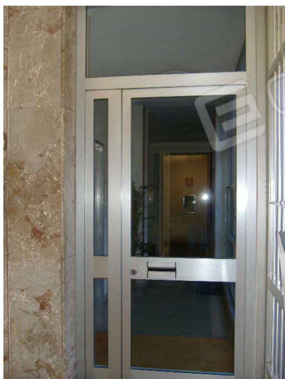
Accesso al vano scala condominiale
