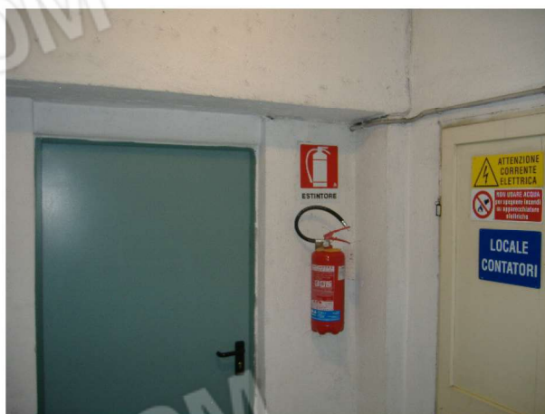
Accesso al P.S1 condominiale
