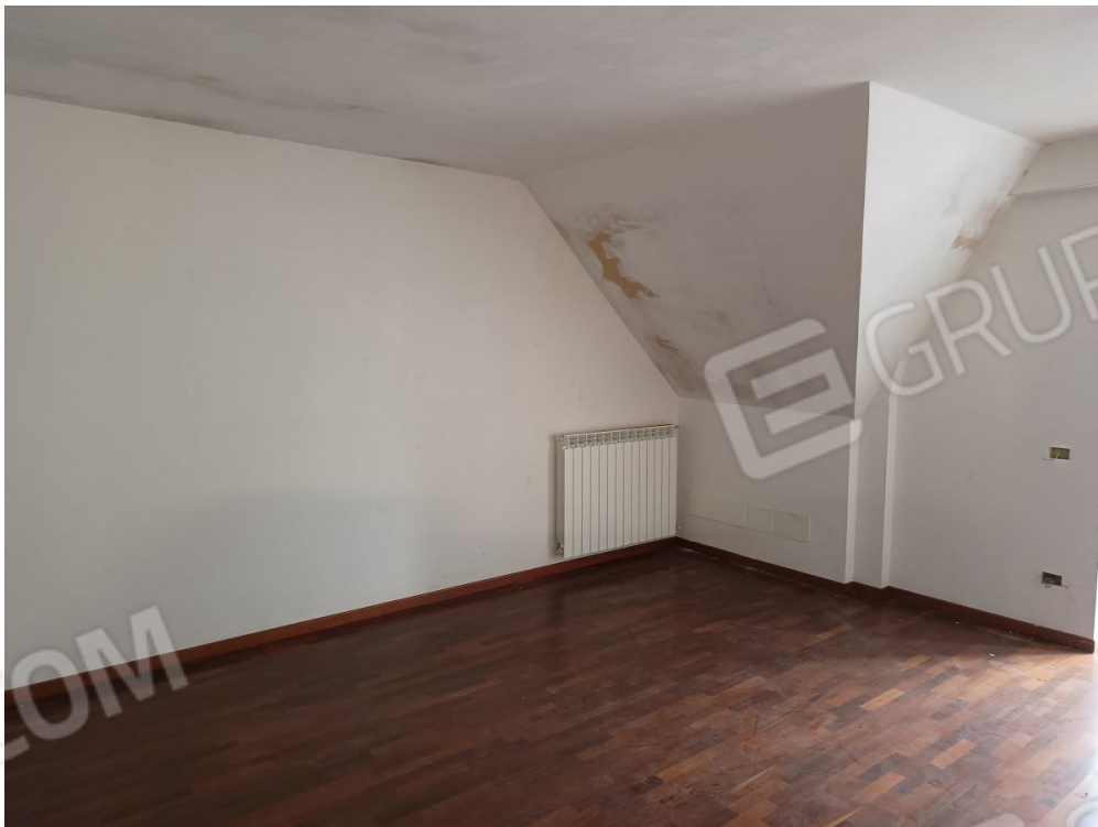
Locale sotto tetto
