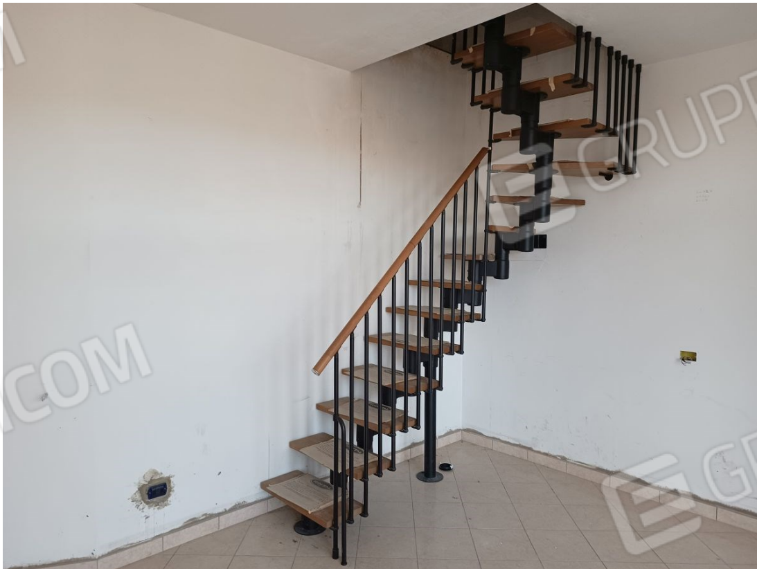
Scala di collegamento al sotto tetto
