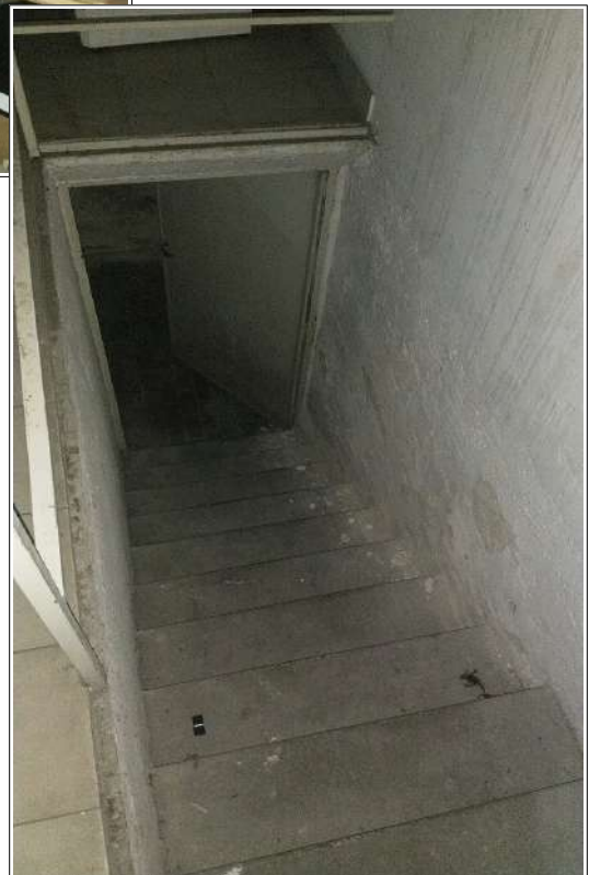
La stretta scala che dal laboratorio conduce al piano interrato
