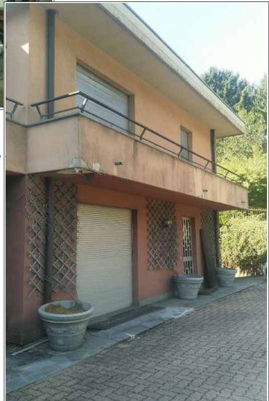
Le facciate esterne: al piano terra i locali ad uso ufficio, al piano primo l'abitazione
