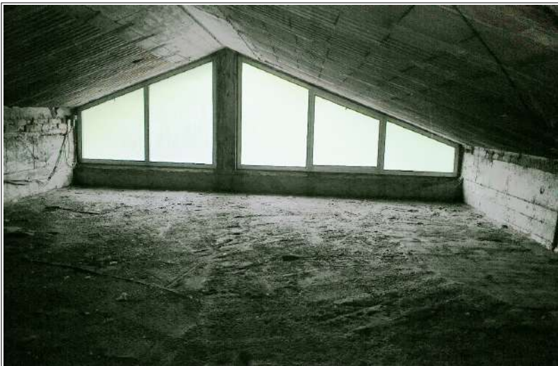
La zona del sottotetto meno accessibile
