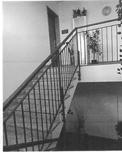
Scala condominiale di accesso al piano
