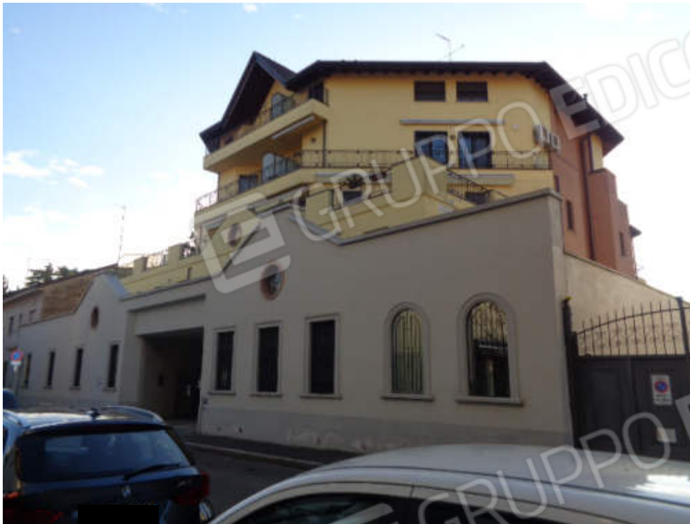
FOTO 1 Vista esterna – Fronte strada
