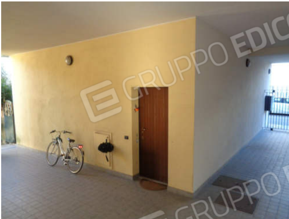
FOTO 3 Vista esterna PT – Ingresso dall’atrio comune
