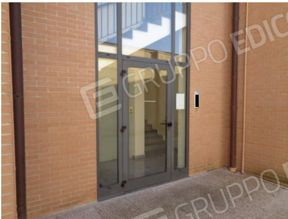
FOTO 11 Vista esterna PT – Accesso al vano scala B per la cantina
