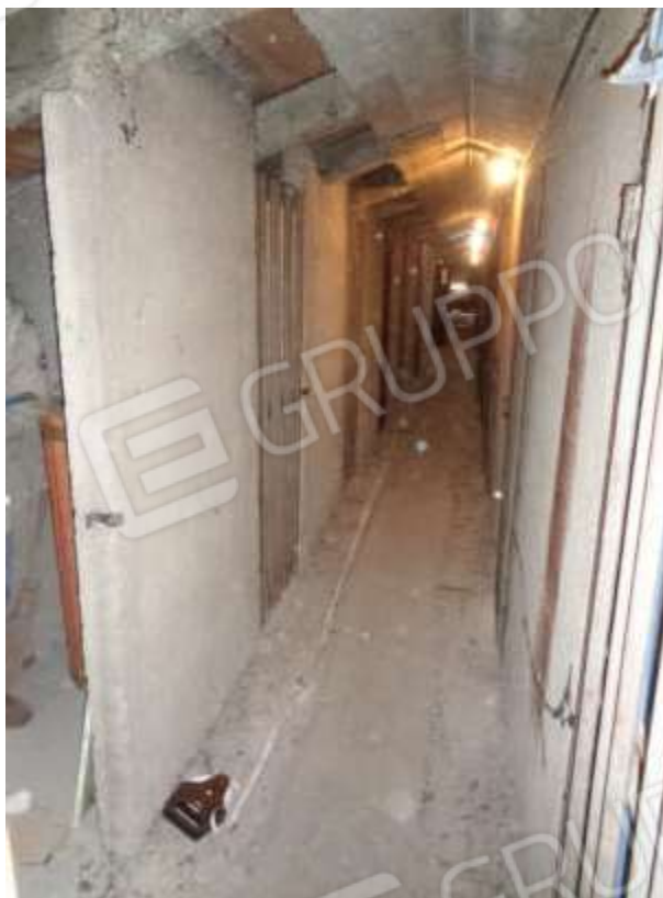
FOTO 19 Vista esterna – Disimpegno comune sottotetto
