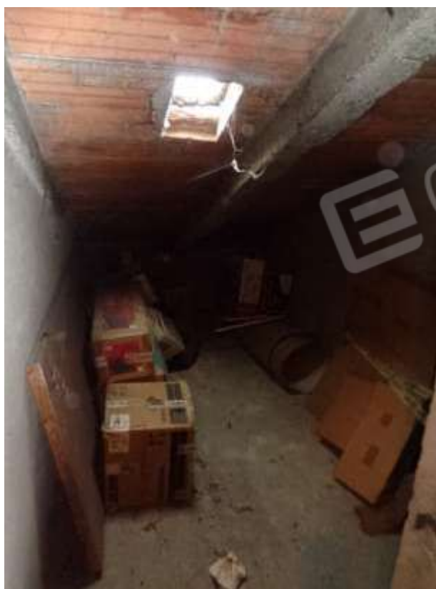
FOTO 20 Vista interna – Locale sottotetto
