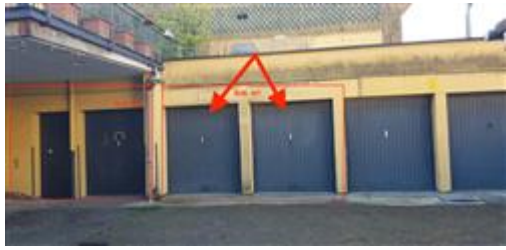
BOX AUTO DI CUI AL MAPPALÉ 752 SUB. 507: GLI INGRESSI
