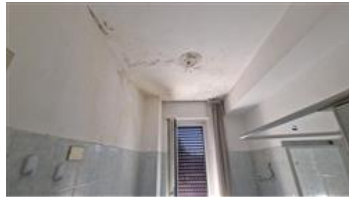
infiltrazione bagno
