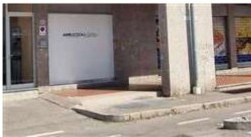
botola accesso cabina Enel interrata
