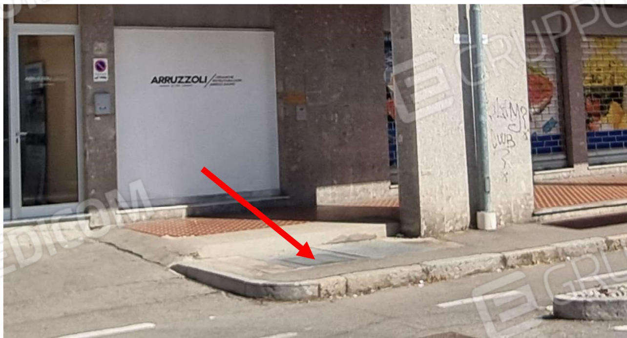
BOTOLA CABINA ENEL
