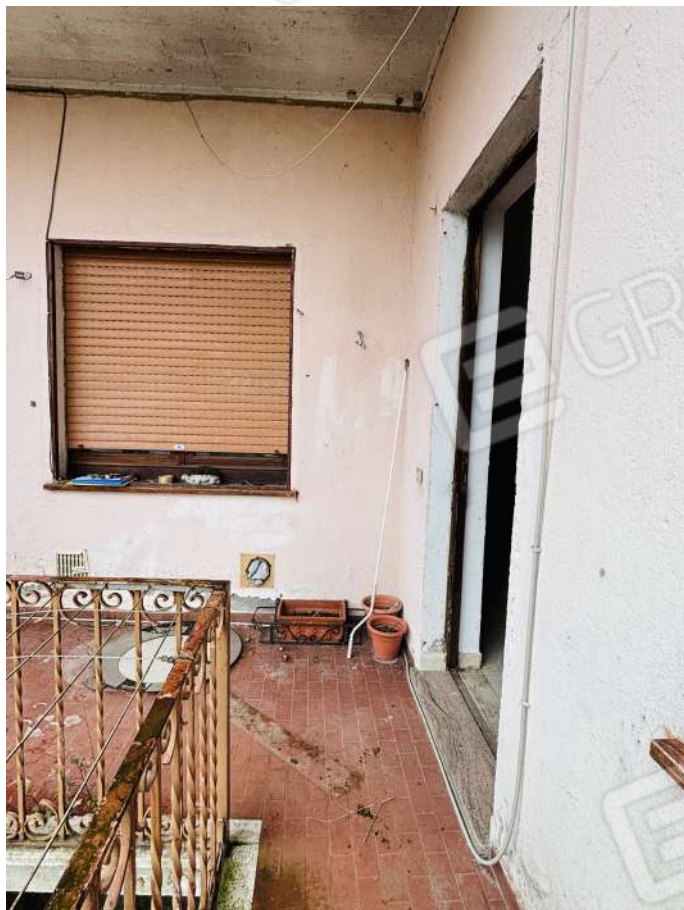
Fotografia 23. Lotto B. Balcone.
