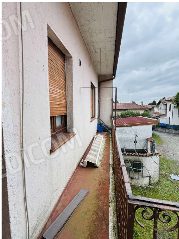
Fotografia 24. Lotto B. Balcone.
