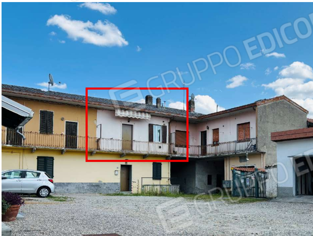
Fotografia 03. Lotto A. Appartamento a piano primo. Fronte.
