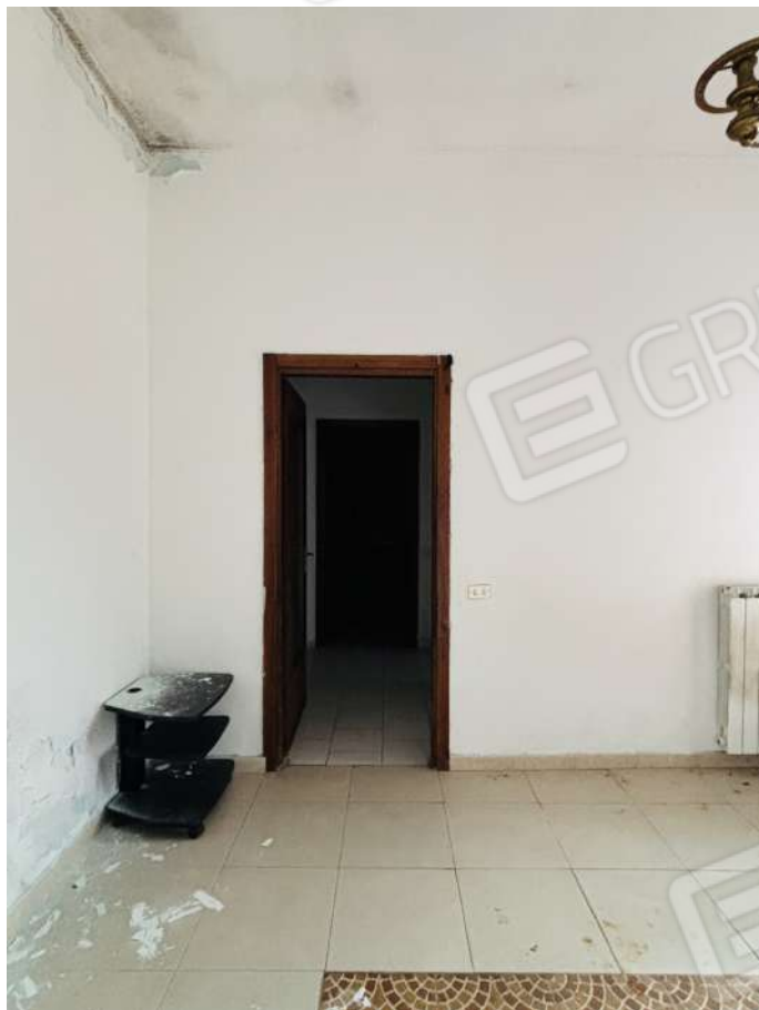
Fotografia 27. Lotto B. Vista su disimpegno.
