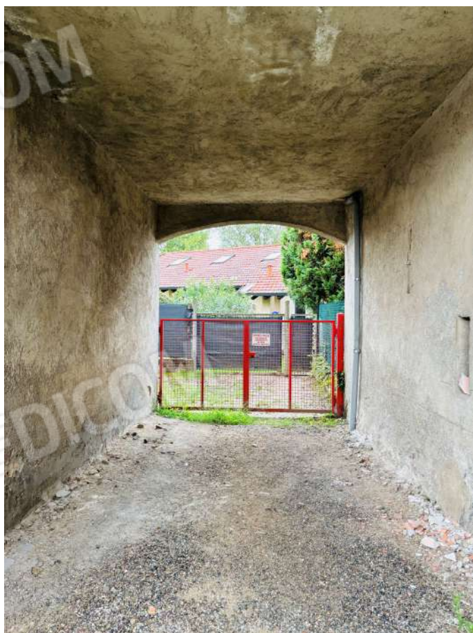
Fotografia 41. Lotto A e B. Accesso al retro.
