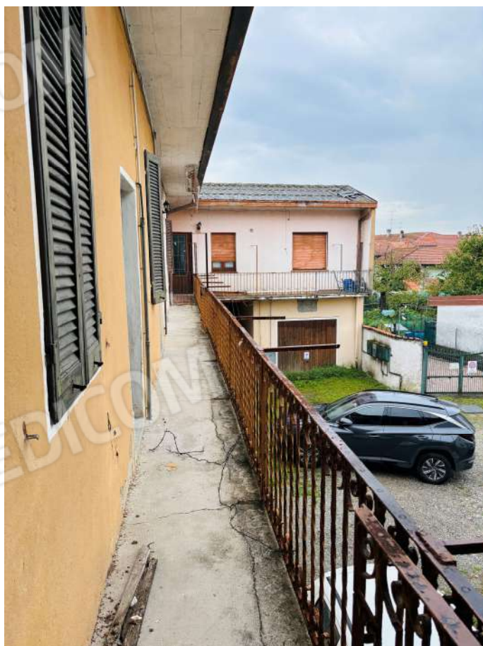
Fotografia 08. Lotto A. Ballatoio comune.
