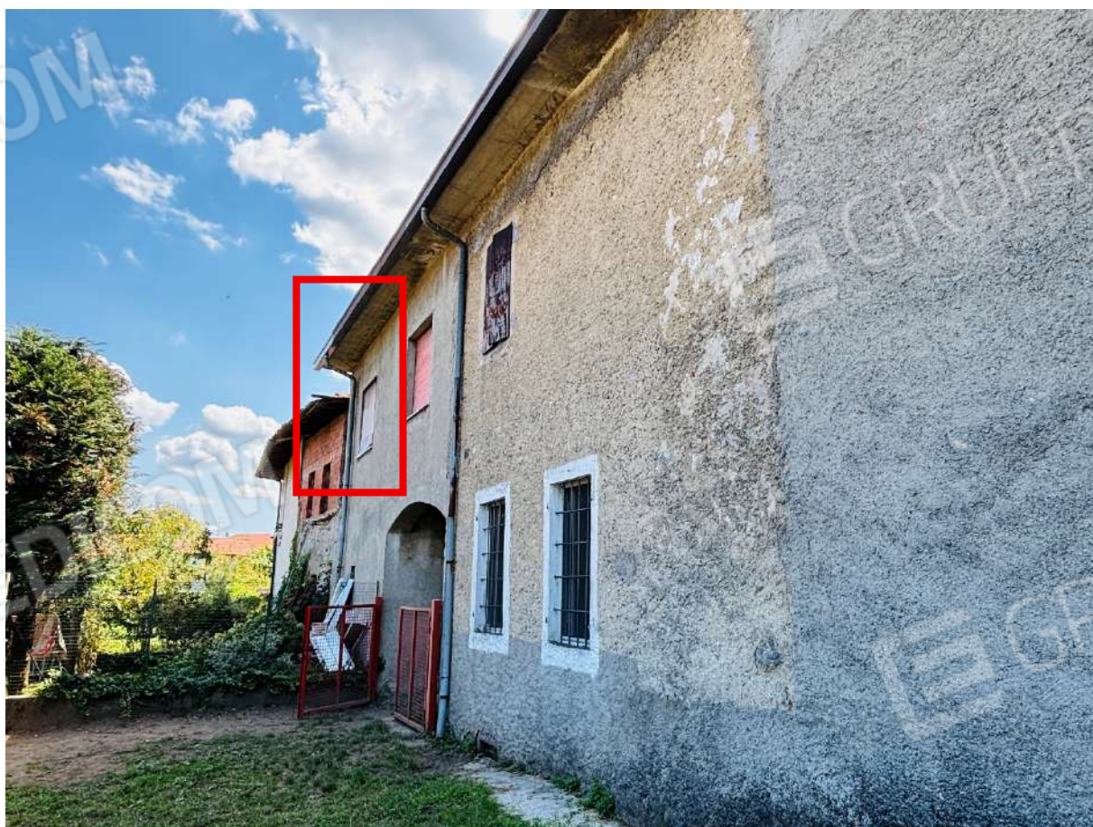
Fotografia 20. Lotto B. Appartamento a piano primo. Retro.
