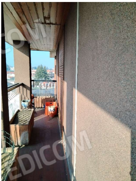
12) Balcone su P.zza Risorgimento;
