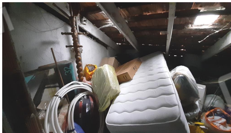
Vista della soffitta ad uso deposito appartenente all'alloggio
