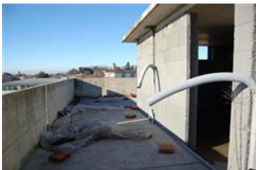
lastrico solare - tubazioni vuote
