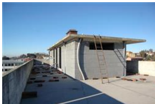
lastrico solare - vano tecnico
