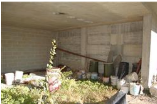
tamponamenti piano interrato
