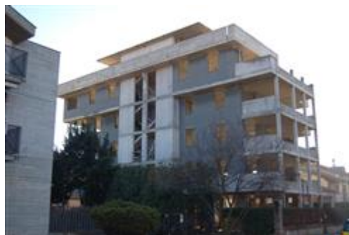
prospetto da via A. Colombo lato nord-ovest
