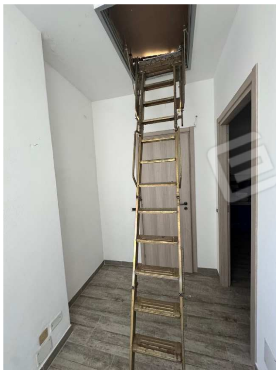
Vista delle scale d'accesso al sottotetto
