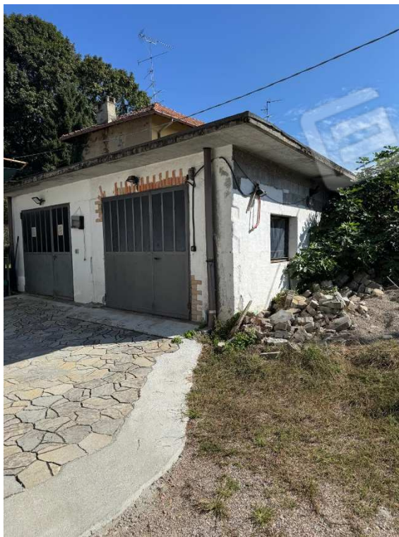
Vista del box dall'esterno
