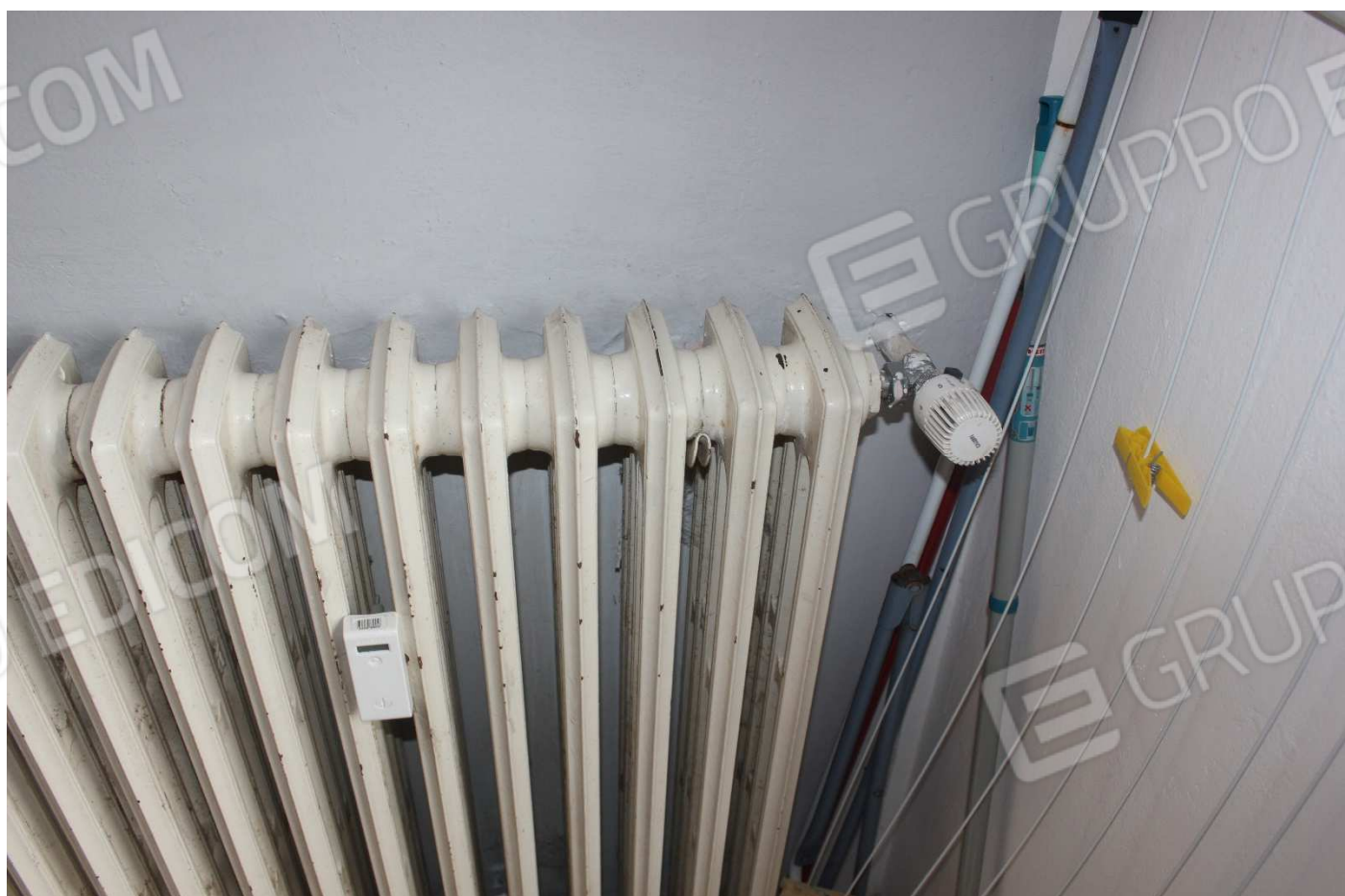
Foto 10 – Radiatori in ghisa con termovalvole e contabilizzatore di calore
