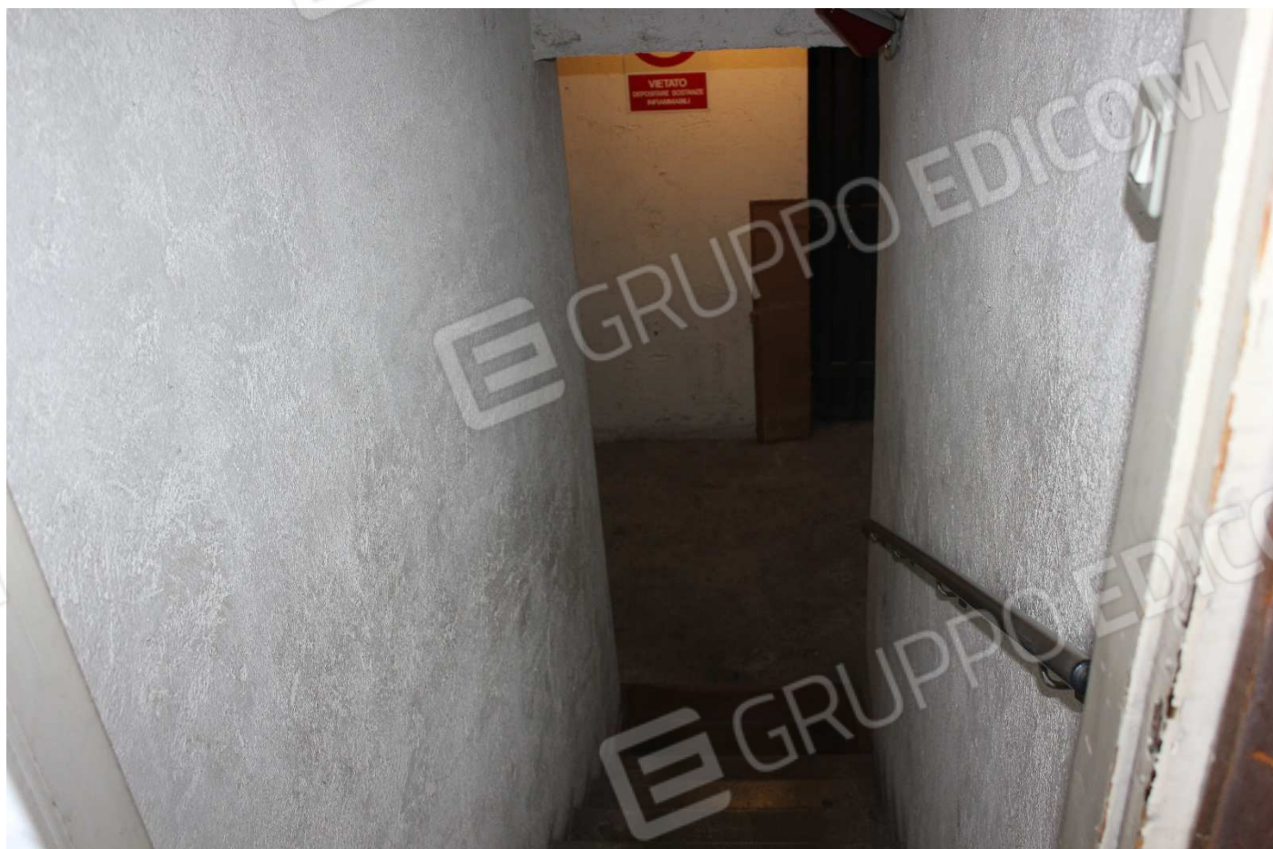
Foto 15 – Vano scale vs piano seminterrato
