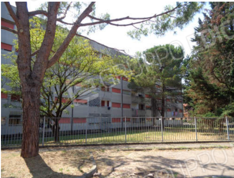
FOTO 5 Vista esterna – Fronte nord-est fabbricato
