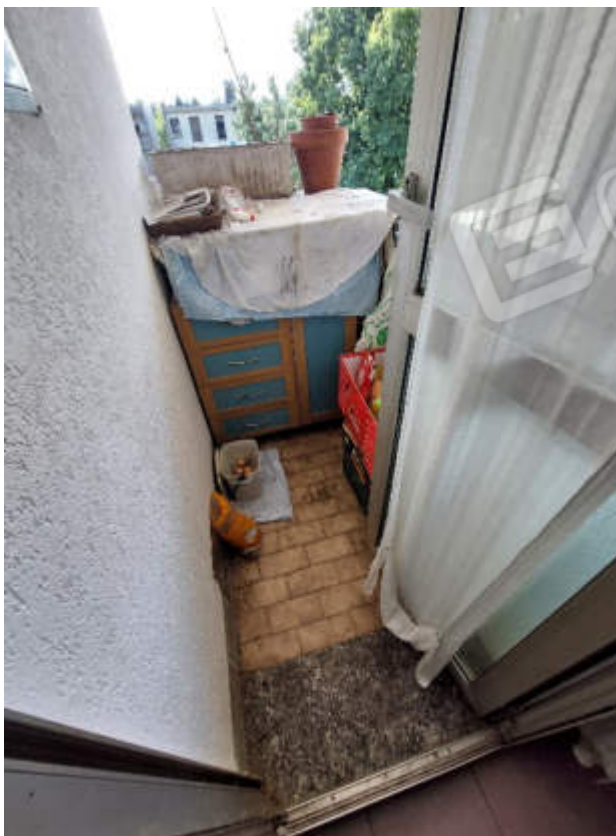
FOTO 10 Vista esterna P4 – Balcone sud-ovest
