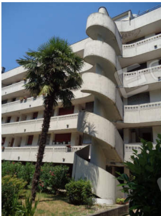
FOTO 4 Vista esterna – Accesso al vano scala comune
