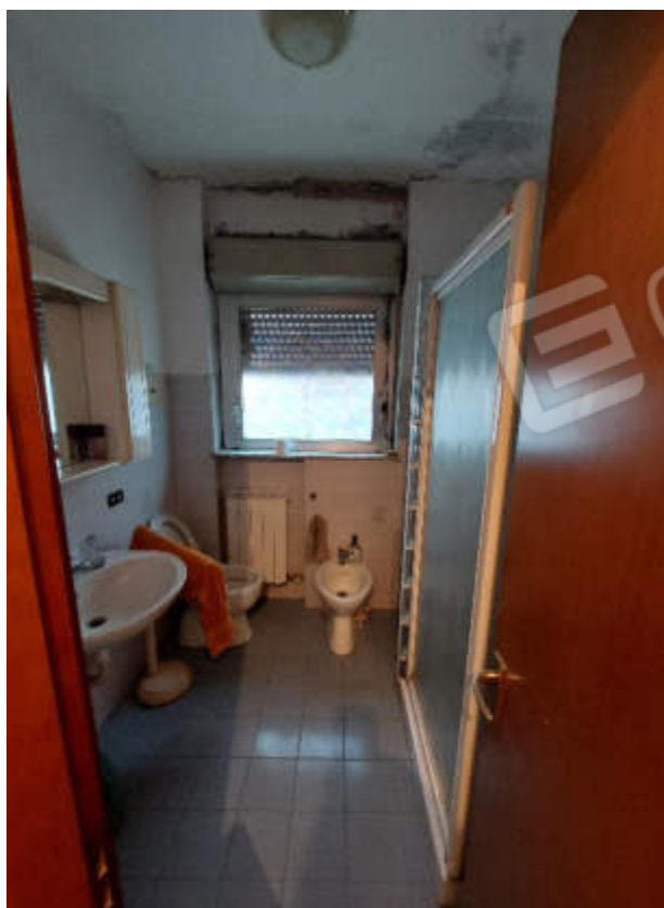
FOTO 14 Vista interna P4 – Bagno
