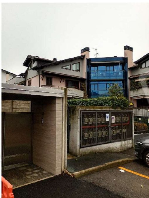
3) Vista del fabbricato con particolare dei contatori,
