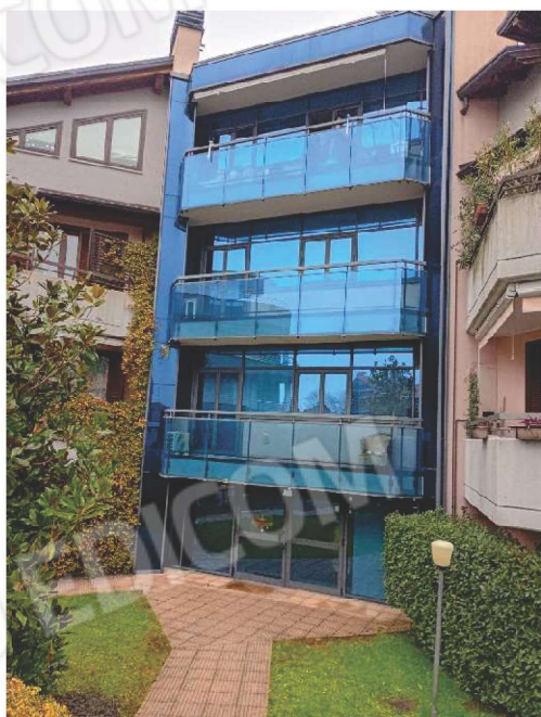
2) Particolare della facciata centrale sui balconi,
