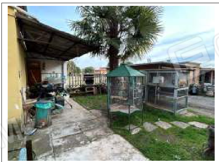
25. TETTOIA IN ETERNIT – SUL FIANCO DEL BOX
