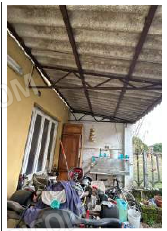
26. PARTICOLARE DELLA TETTOIA IN ETERNIT
