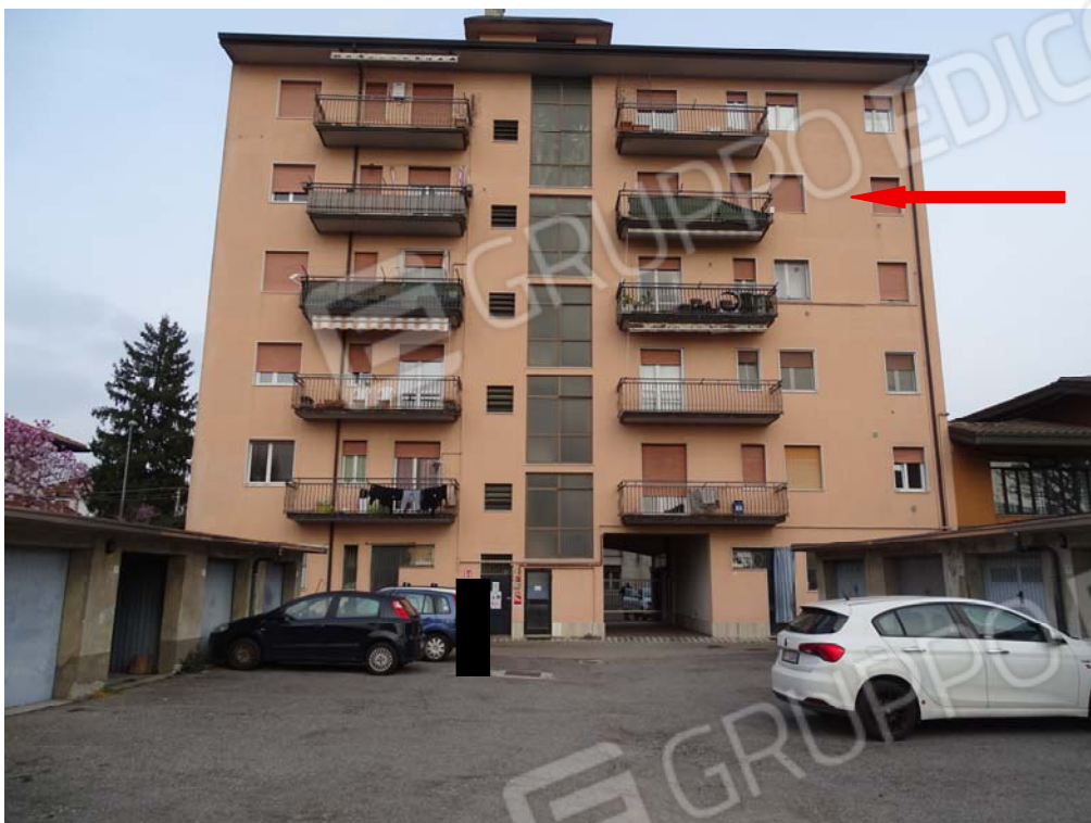
Vista fabbricato interno cortile e posizione appartamento
