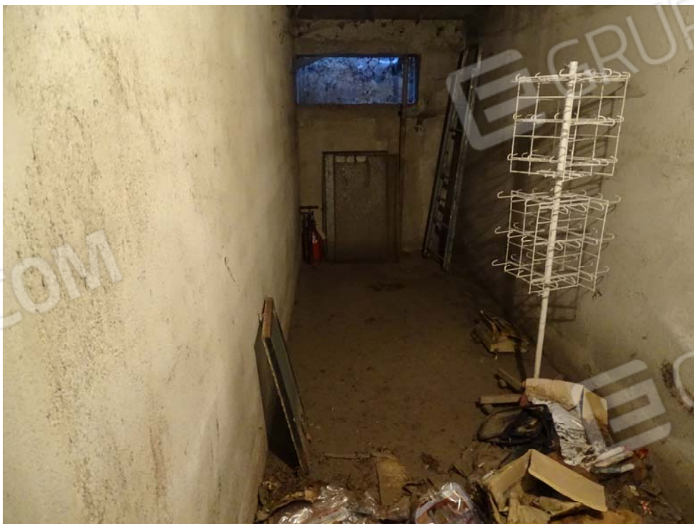
Vista interna cantina
