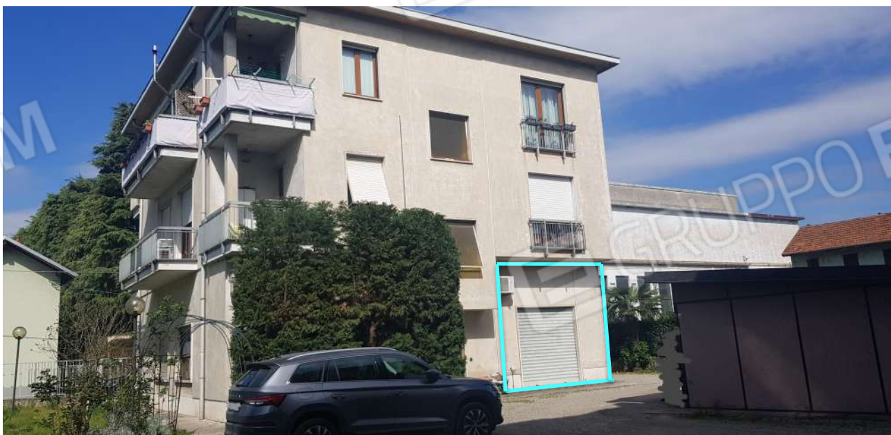
IL PROSPETTO SUGLI SPAZI COMUNI INTERNI
