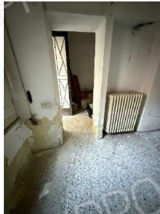
Foto 10 – Interno – Primo locale ex camera
