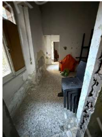
Foto 12 – Interno – Secondo locale ex camera
