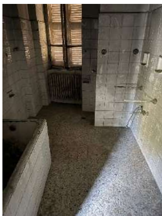
Foto 17 – Interno – Bagno (PT)
