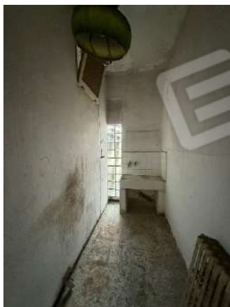
Foto 15 – Interno – Cucinino (PT)
