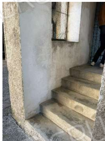
Foto 6 – Esterno – Scala ingresso passaggio coperto
