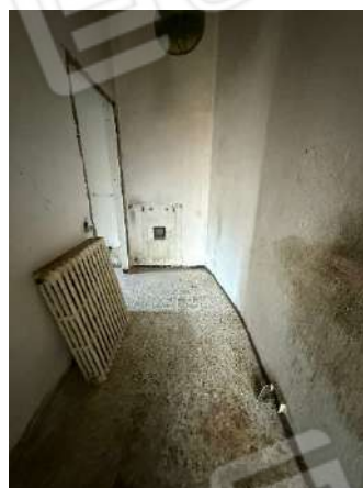
Foto 14 – Interno – Cucinino (PT)
