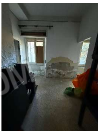
Foto 13 – Interno – Secondo locale ex camera (PT)
