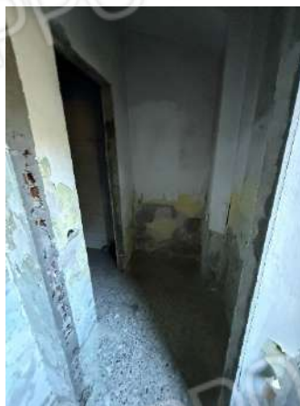
Foto 16 – Esterno – Antibagno (PT)
