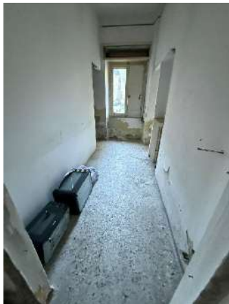
Foto 11 – Interno – Primo locale ex camera
