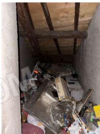
Foto 19 – Interno – Ripostiglio (P4)
