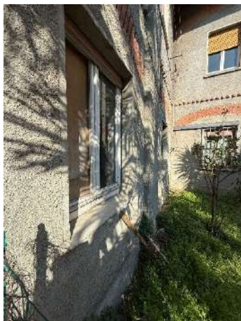
Foto 5 – Esterno – Fronte sub
