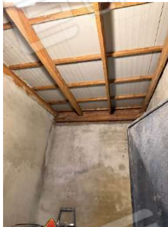
Foto 20 – Interno – Ripostiglio (P4)
